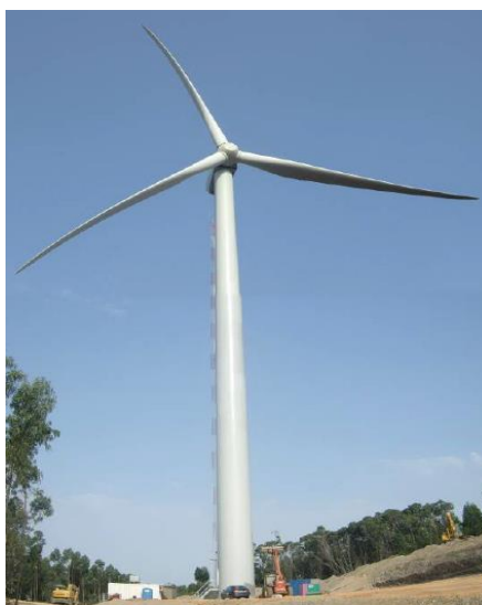
Figura 2.2 – Torre tubular de aço com 80m (REPOWER MM92).
