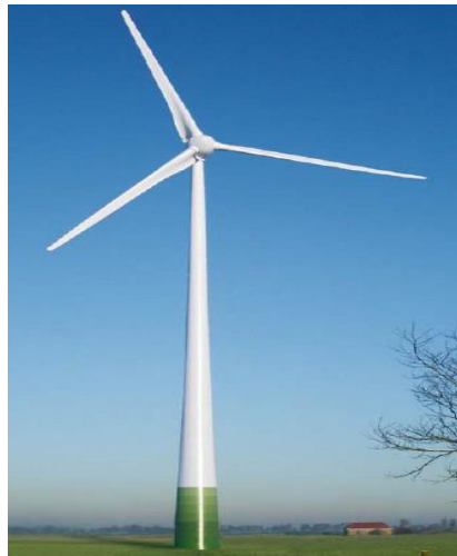
Figura 2.3 – Torre de betão, (Enercon).
