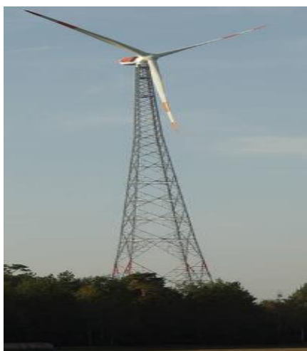
Figura 2.5 – Torre treliçada em aço com 160m de altura (SeeBA).
