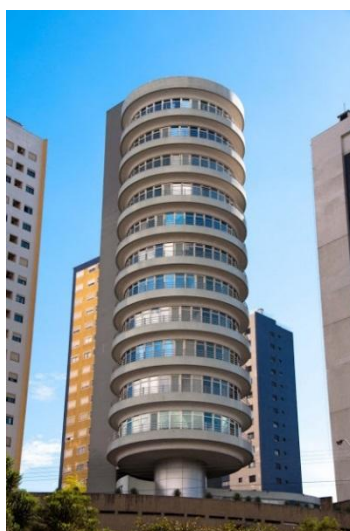
Figura 2.2.5 Prédio Rotativo Suite Vollard, situado no Brasil [26]
