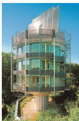
Figura 2.2.3 Heliotrope Rotating House, situada em Freiburg [24]
