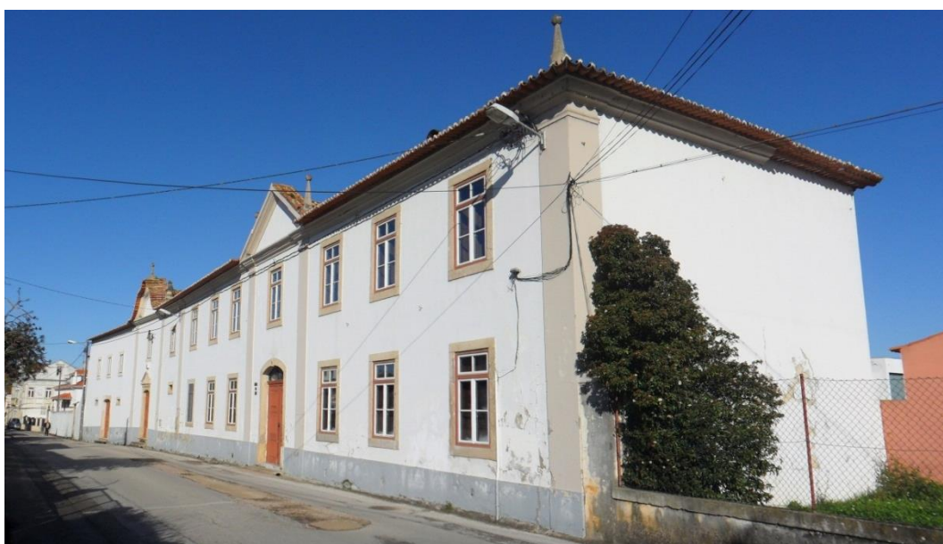
Figura 3.2 – Vistas das fachadas do edifício antigo
