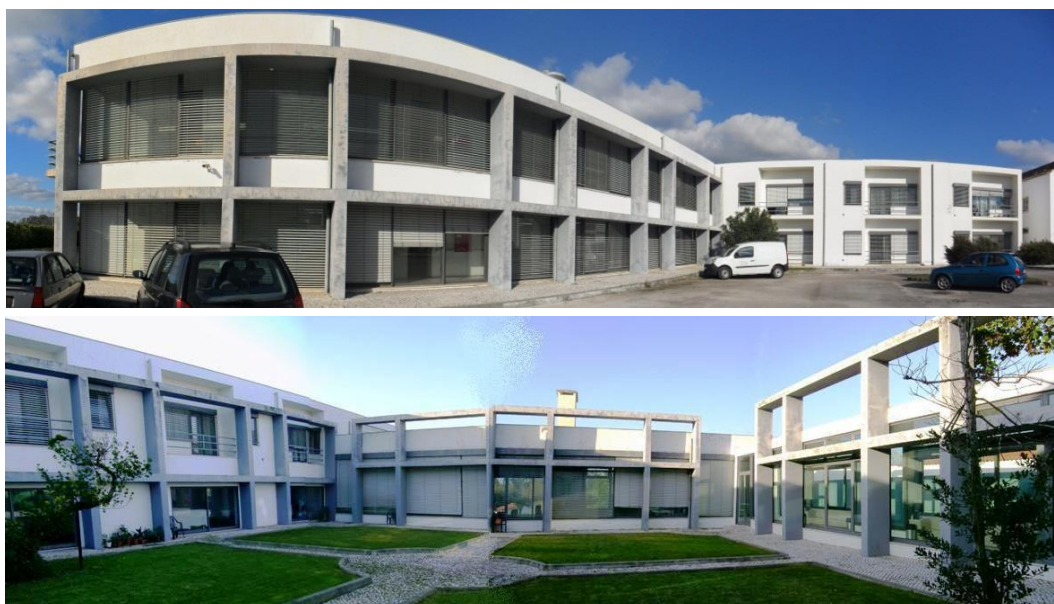
Figura 3.1 – Vistas das fachadas do edifício de construção recente
