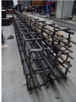
Figura 3.5 – Armaduras após montagem
