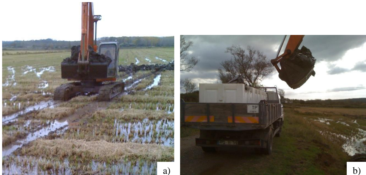
Figura 3.2 - Recolha de solo do Baixo Mondego: a) recolha do solo com o auxílio de uma retroescavadora; b) colocação do solo em caixas, de modo a serem transportadas para laboratório.
