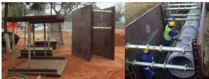
Figura 5.6 – Escudo ou caixa de trincheira.
