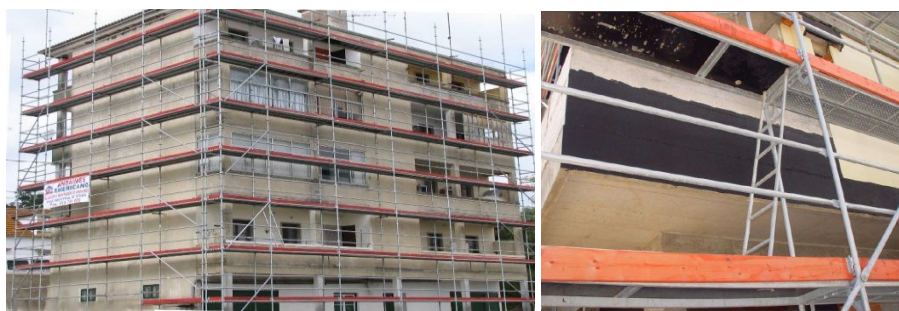
Figura 5.7 – Plataforma de trabalho tipo andaime.
