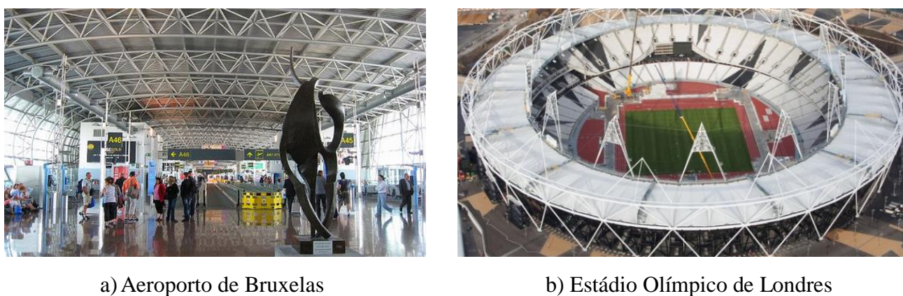
Figura 1.2 – Exemplos de estruturas com perfis tubulares
