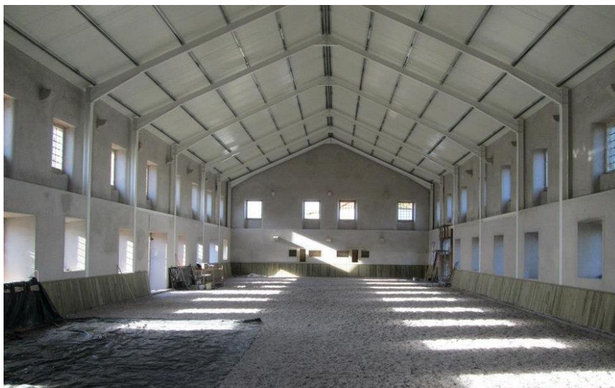
Figura 1.4 – Pavilhão industrial com travessas com elevada inclinação
