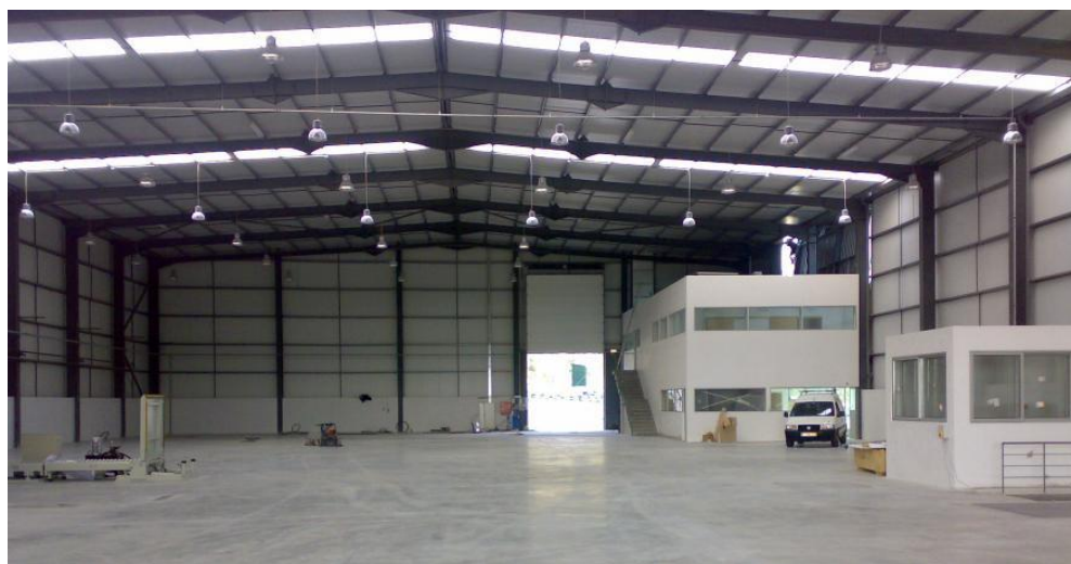
Figura 1.5 – Pavilhão industrial com travessas com baixa inclinação
