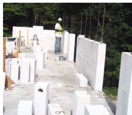
Figura 2.8 – Montagem de paredes com blocos reforçados em BAA (State University of New York, Stony Brook)
