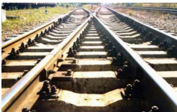
Figura 2.3 – Travessas monobloco de caminho-de-ferro (Rostovskaya et al , 2007)
