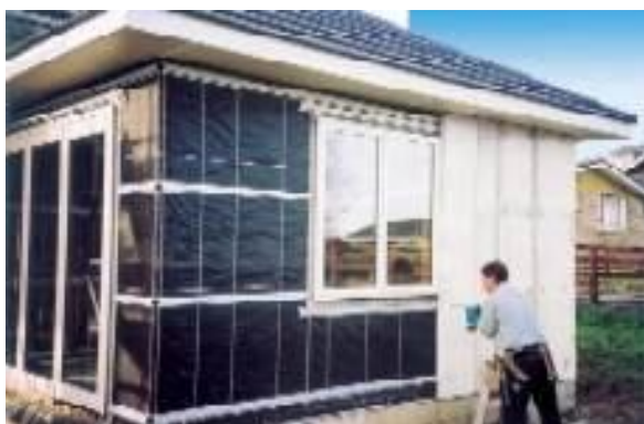
Figura 2.7 – Revestimentos de fachada (fabricados pela Hebel).
