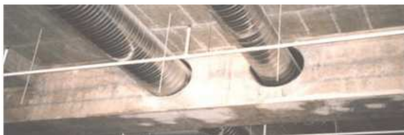
Figura 2.7 – Viga de betão com abertura circular, Amiri et al. (2011).
