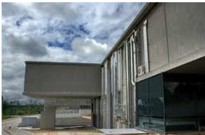
Figura 6.9 – Aspeto da estrutura construída
