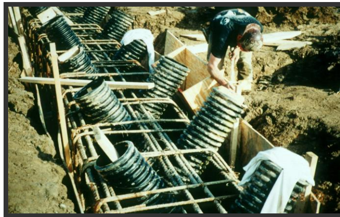
Figura 3.1 – Microestacas de tipo I (Hayward Baker, 2002)
