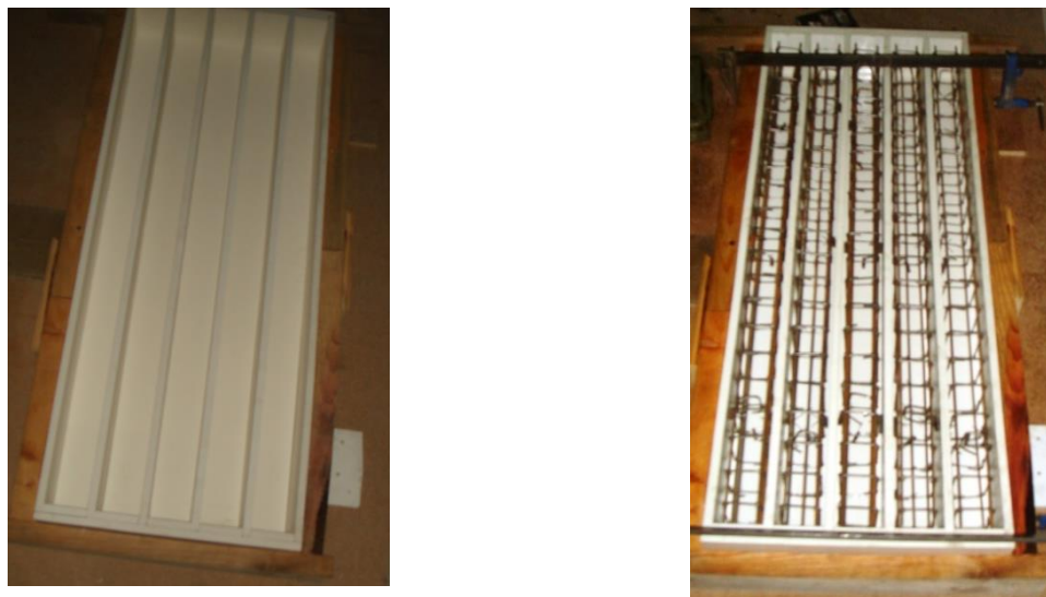
Figura 3.1 – Cofragem usada para a construção das vigas, sem e com armadura, respectivamente.
