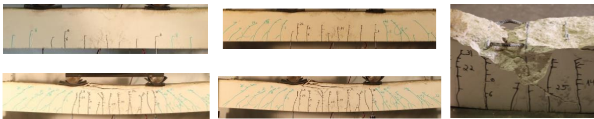
Figura 4.45 – Evolução das fendas na Viga META-4F6 para cargas de 8kN, 22kN, 30kN, e 24kN, e pormenor da posição das fendas em relação aos estribos.
