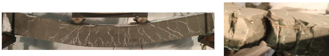
Figura 4.57 – Viga CIN-2F6 durante o ensaio e pormenor da rotura.
