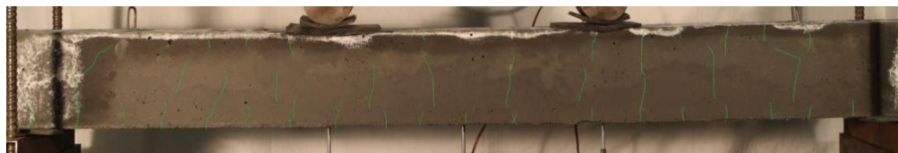
Figura 4.64 – Fendas na Viga CIN-4F8 antes de se iniciar o ensaio.
