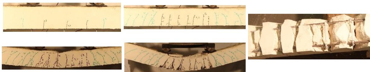
Figura 4.35 – Evolução das fendas na Viga META-2F6 para cargas de 5kN, 12kN, 17kN e 20kN, e pormenor da posição das fendas.
