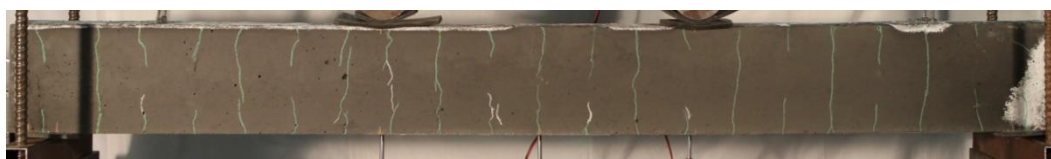
Figura 4.58 – Fendas na Viga CIN-3F6 pouco antes do início do ensaio.
