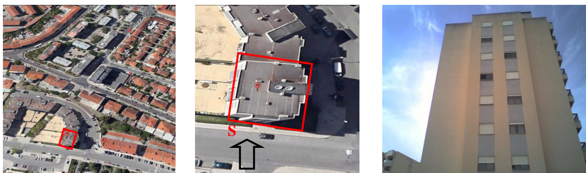
Figura 3.27- Localização e orientação da fachada do Edifício H.
