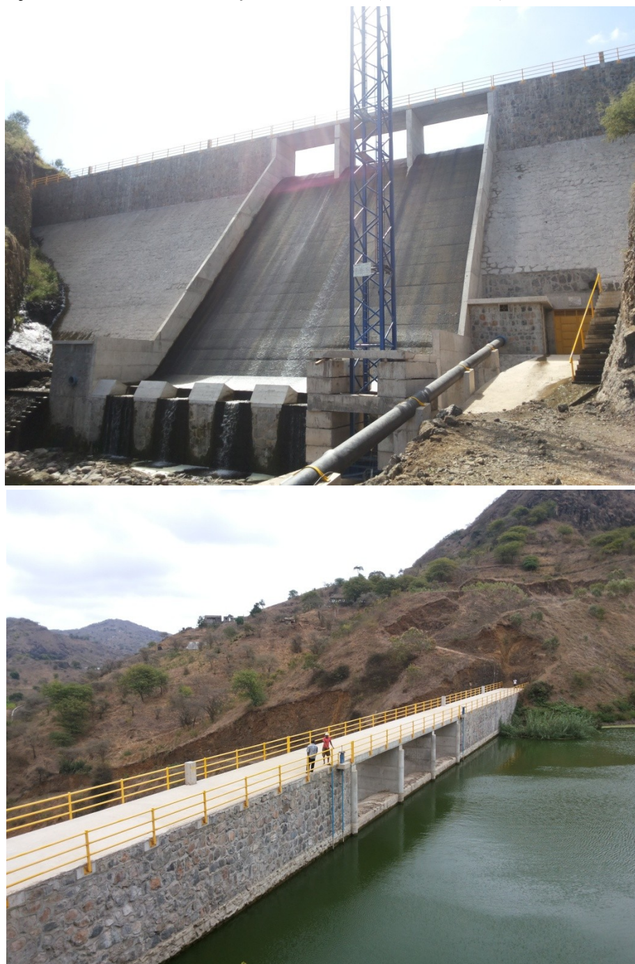
Figura 3.6 – Barragem de Faveta. Paramentos da montante e jusante.
