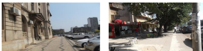
Figura 3.4. À esquerda edifício do município da cidade de Maputo e a direita passeio da Av. 24 de julho, todos sem marcos de incêndio (autor)
