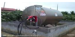
Figura 3.17. Bacia de retenção (mfrural)
