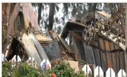
Figura 1.5. Edifício da Escola Americana de Maputo destruído pelo incêndio (Sapo)
