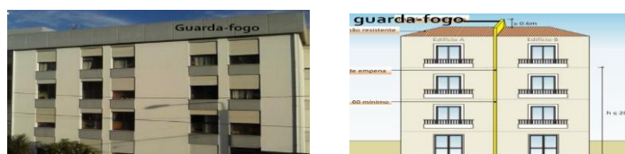
Figura 3.3. Edifícios com guarda-fogo (autor & Segurança Online).
