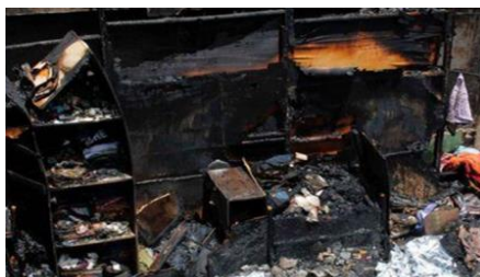
Figura 1.3. Incêndio numa residência no bairro de Xipamanine (jornal Folha de Maputo)
