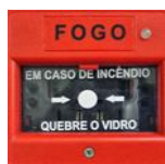
Figura 3.28. Dispositivo de acionamento manual do alarme (blogspot)
