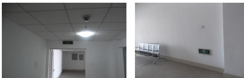
Figura 3.23. Disparidade na altura das placas de emergência, em compartimentos do Estádio Nacional do Zimpeto (autor)
