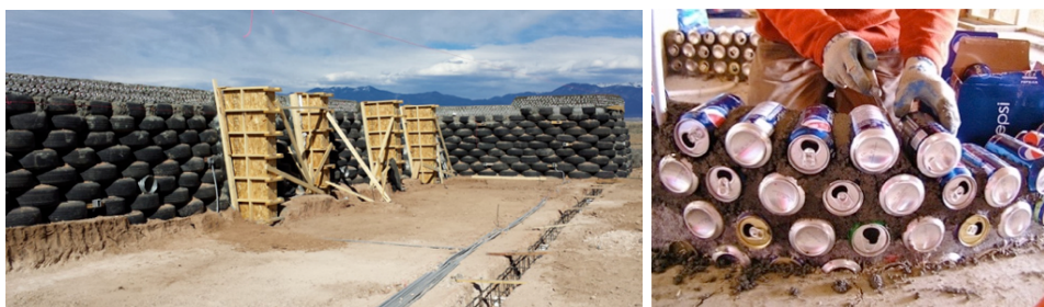
Figura 2.16. (a) Parede de pneu de um earthship em construção [23]; (b) Parede interior [23].
