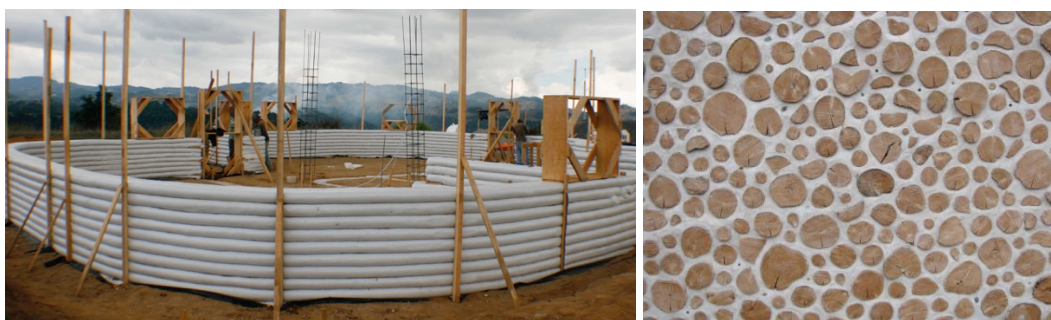
Figura 4.10. Exemplos de paredes com sacos de terra (superadobe) e cordwood [62][63].
