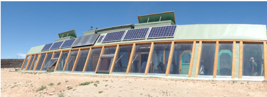
Figura 2.4. Exposição dos painéis solares e fotovoltaicos de um earthship Global Model em Taos [15].
