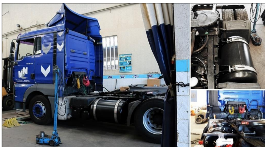
Figura 3.16- Várias vistas do depósito de combustível já instalado e alinhado.
