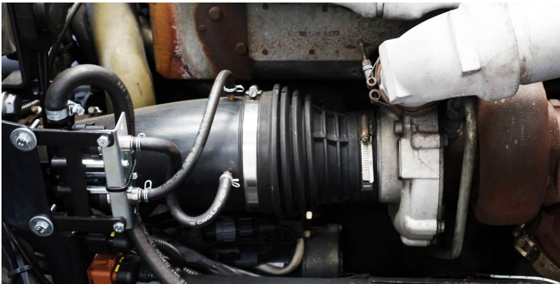
Figura 3.9- Injetores Barracuda e bicos de injeção já instalados.
