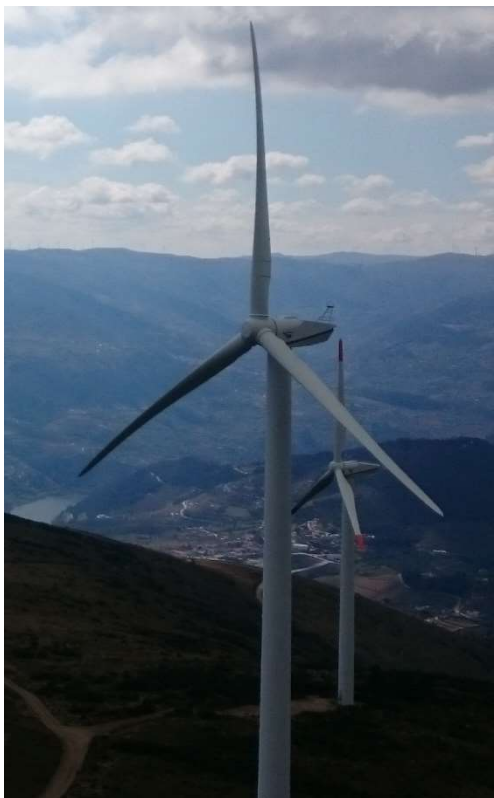
Figura NB.2 – Aerogerador de eixo horizontal do parque eólico Teixeira
