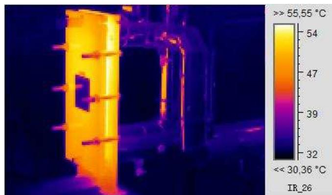
**Figura 4.2.** Imagem termográfica em permutador de calor sem isolamento.
