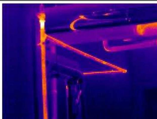
**Figura C.3** Imagem termográfica de tubagem sem isolamento térmico.
