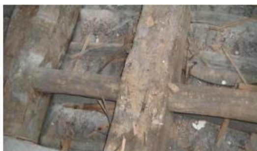
Figura 2.3 – Tarugamento em vigas de seção circular. Edifício do largo de São Domingues, Porto (Ilharco, 2008).
