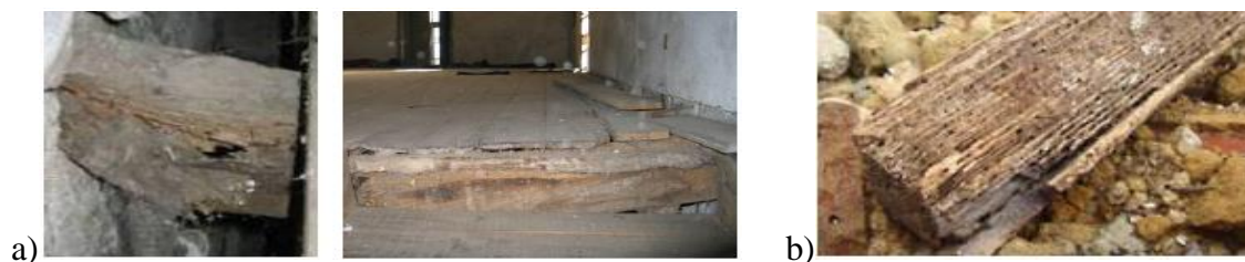
Figura 2.6 – Elementos de madeira atacados por insetos xilófagos: a) térmitas (Ilharco, 2008); carunchos (InovaDomus, 2013).
