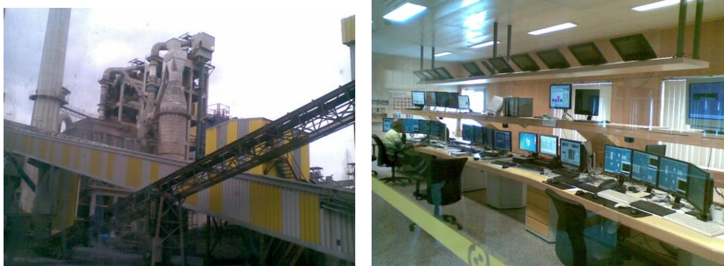
Figura IV. 7.1. A – Instalações da unidade fabril da Cimpor em Souselas
