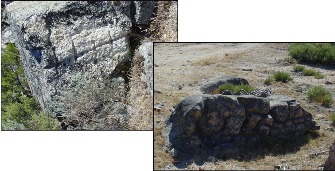
Fotografia 27- Fissuras poligonais pouco desenvolvidas e de forma quadrada (em cima), e bem desenvolvidas (em baixo).
