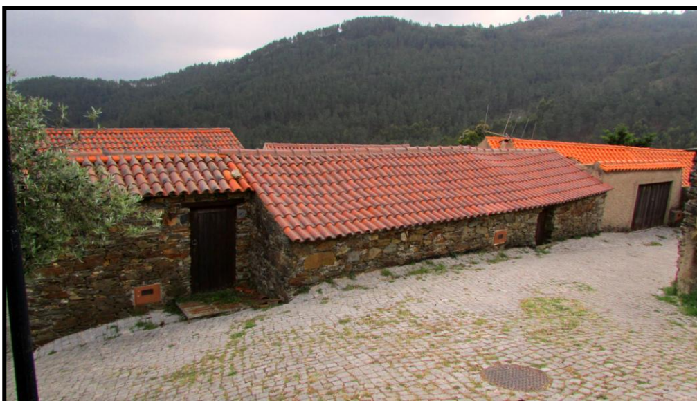
Figura 101 – Vista sobre edificações intervencionadas pelo Programa das Aldeias do Xisto, na Comareira.
