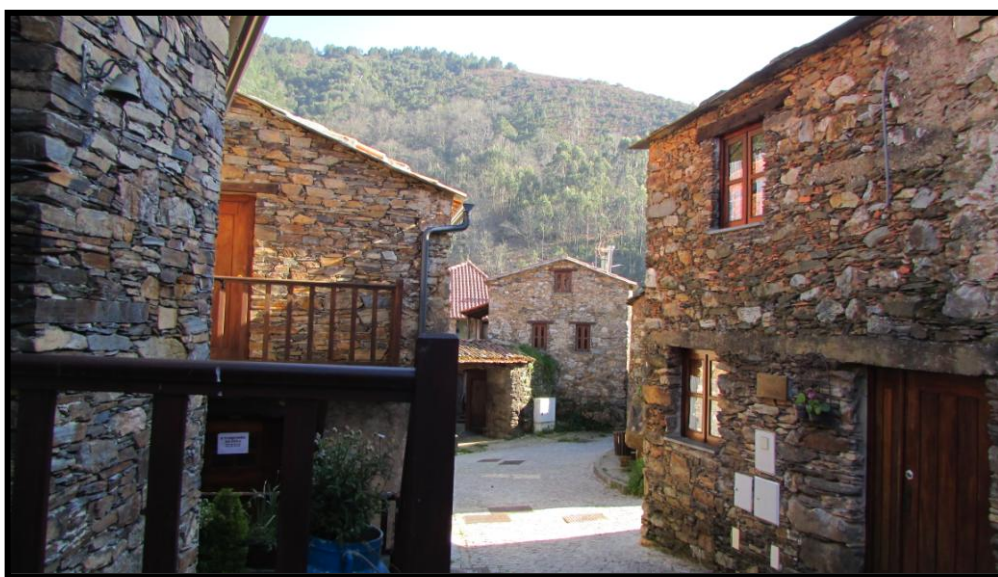
Figura 107 – Vista sobre parte do edificado da Pena, em excelente estado de conservação.
