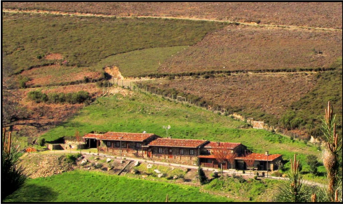
Figura 98 – Edifício da Banda D' Além, na Aigra Velha, em 2013.
