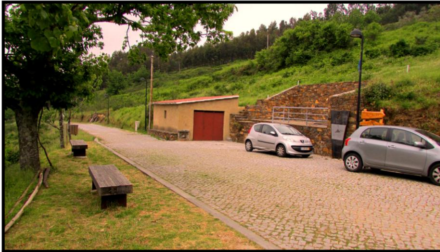
Figura 83 – Vista sobre o Largo da Fonte (Aigra Nova), um dos espaços intervencionados pelo Programa das Aldeias do Xisto.
