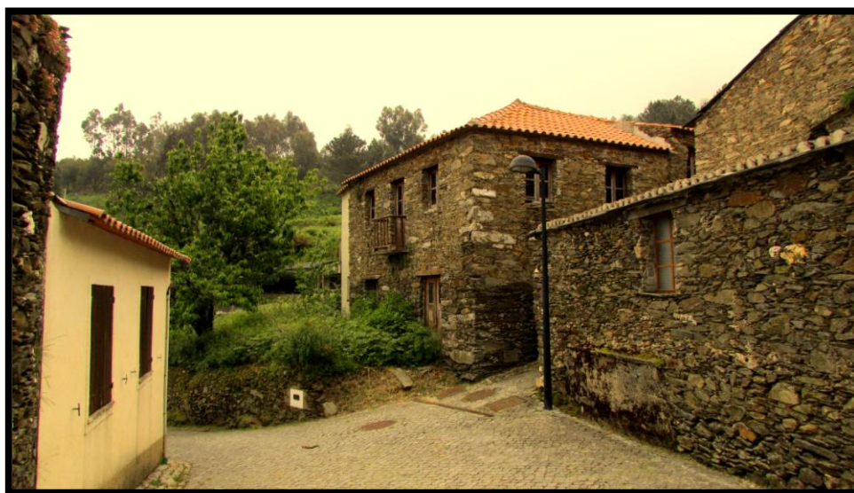
Figura 80 – Vista sobre alguns dos edifícios intervencionados e arruamentos, na Aigra Nova.
