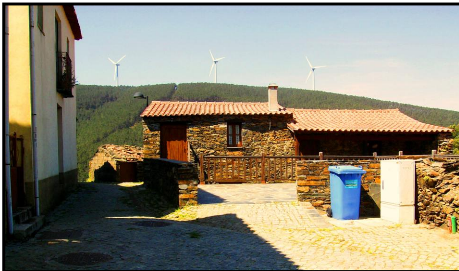
Figura 79 – Vista sobre alguns dos edifícios intervencionados e arruamentos, na Aigra Nova.
