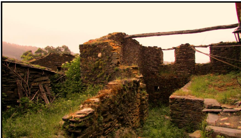
Figura 78 – Vista sobre algumas das habitações em ruínas na Aigra Nova.
