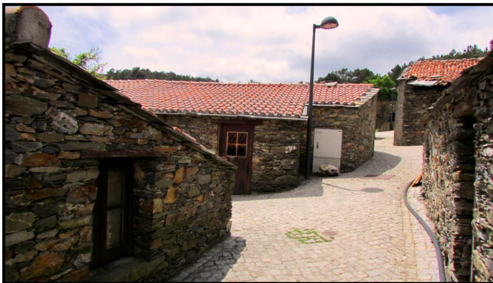
Figura 94 – Vista sobre algumas das edificações intervencionadas na Aigra Velha.
