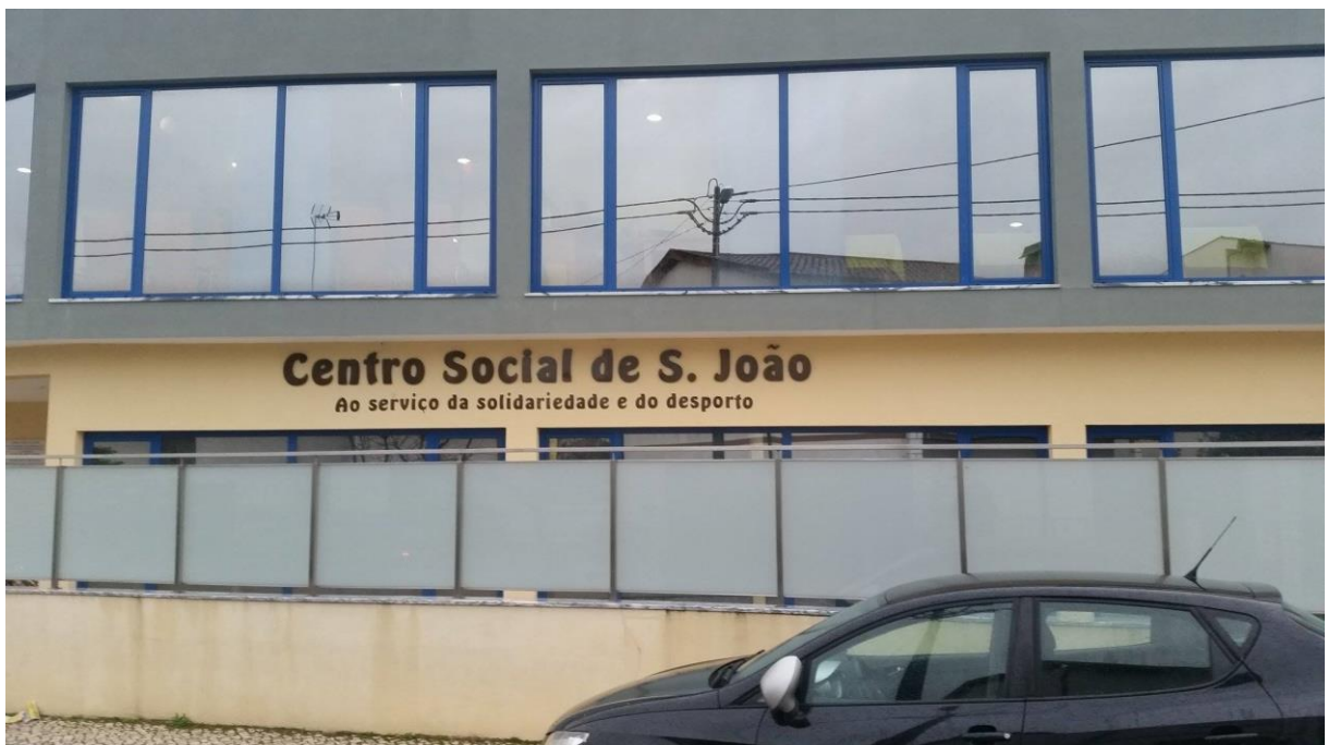
Imagem 19: Pavilhão do Centro Social de S. João, com capacidade para 400 espectadores. Fonte: autor (2015).
