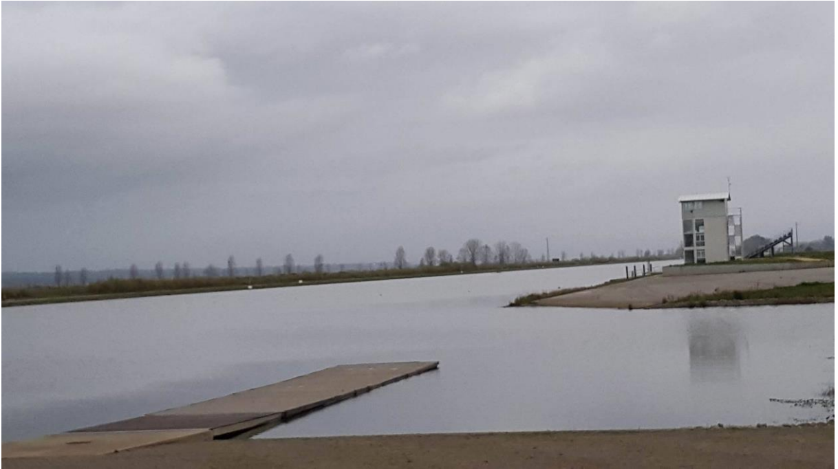
Imagem 24: Centro de Alto Rendimento de Montemor-o-Velho. Ao fundo, à direita, é possível ver as bancadas. Fonte: autor (2015).
