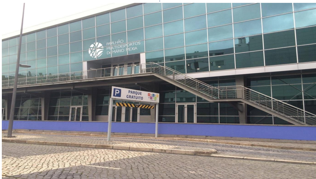
Imagem 10: Pavilhão Multidesportos Mário Mexia, cuja gestão é da Câmara Municipal de Coimbra. Fonte: autor (2015).
