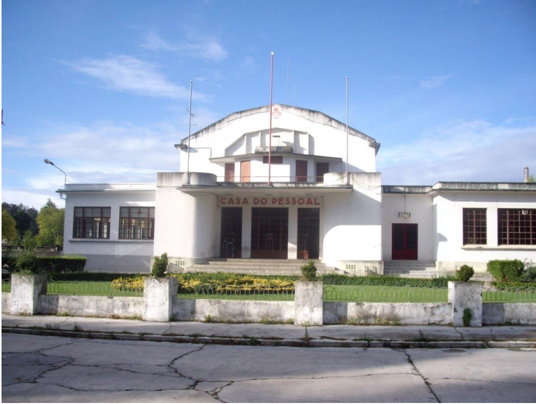
Fotografia 13 - Edifício da Casa do Pessoal do Bairro do Pessoal
