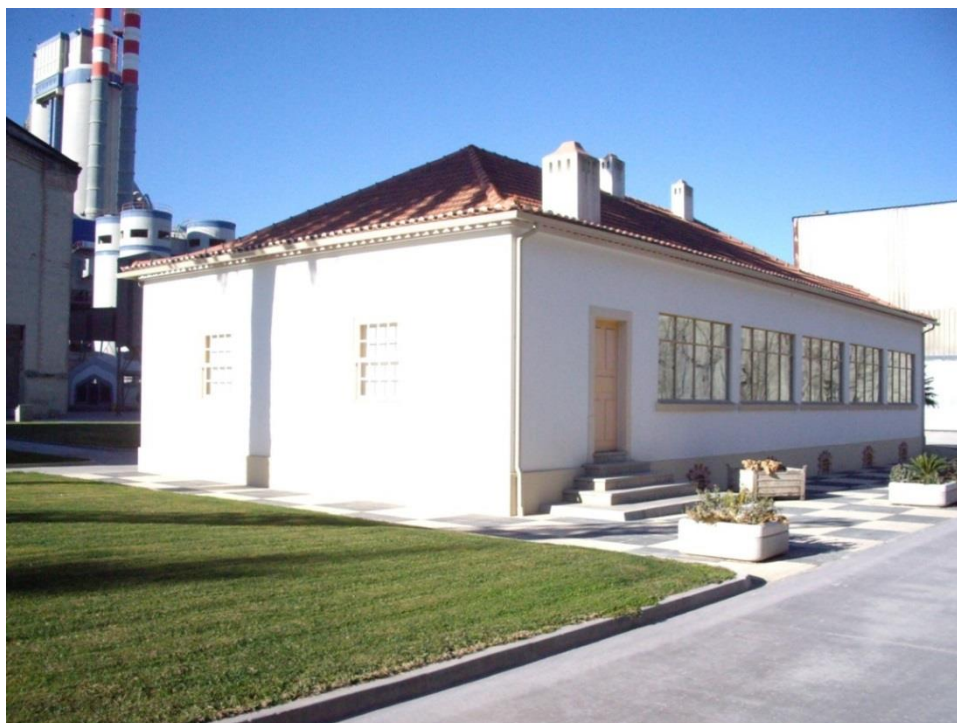
Fotografia 2 - Edifício do Centro de Documentação do Museu do Cimento
