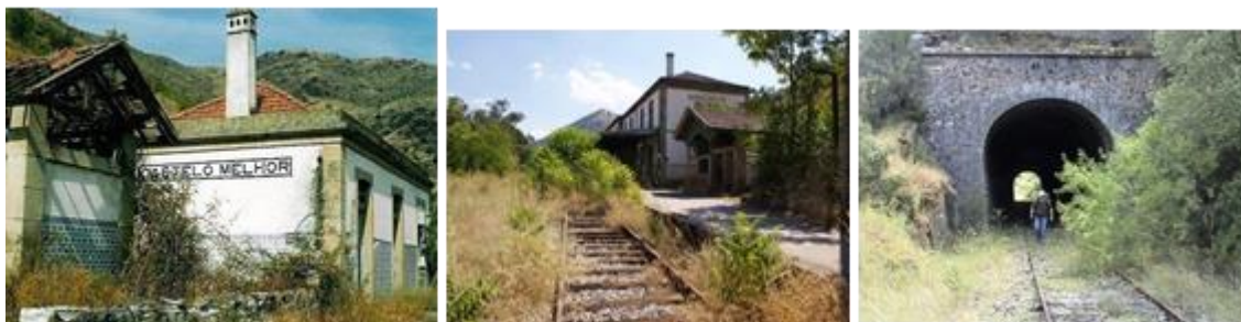
Figura 11 – Exemplos património dos caminhos-de-ferro abandonado e degradado [fonte: www.comboios.net ]
