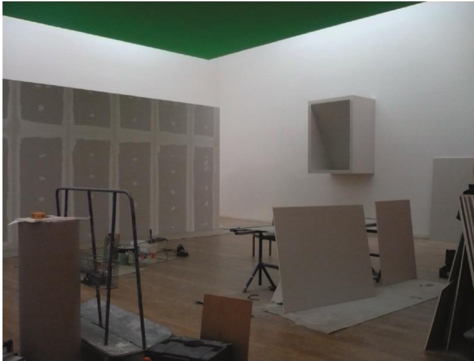
Construção da parede para a obra Político dos Enganos , 2010 e das estruturas para a obra Nichos , 2011
