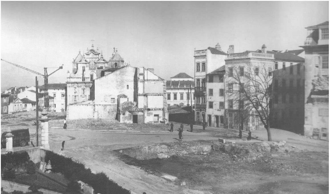
Fig. 25 e 26 Demolições de edifícios na Rua Larga
