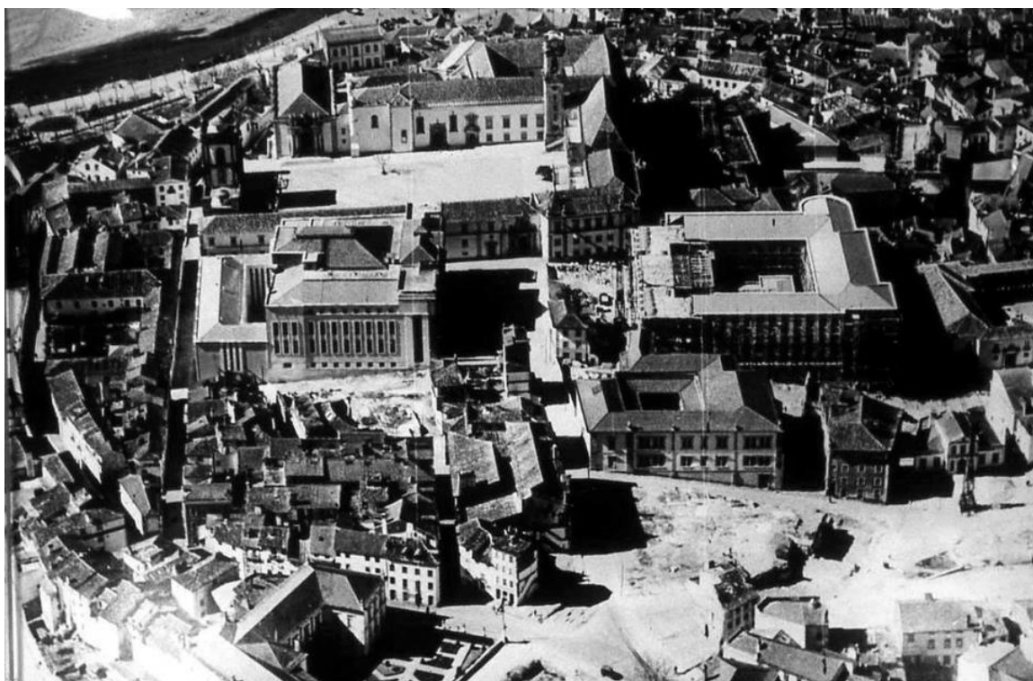
Fig. 39 Vista aérea através de outra perspectiva, já com alguns edifícios demolidos.
