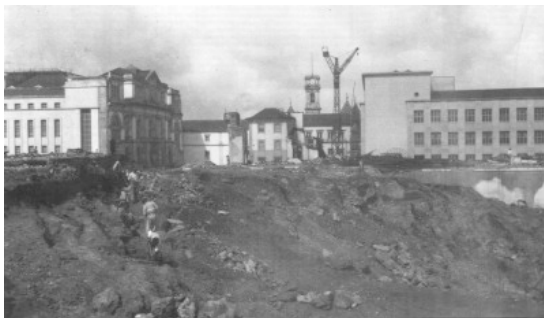
Fig. 29 Desolação da Alta após demolições
