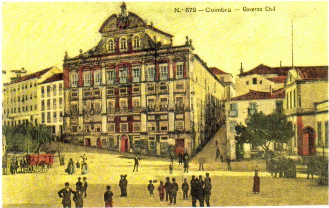
Fig. 34 Ilustração do Edifício do Governo Civil, no Antigo Largo da Feira, em frente à Sé Nova
