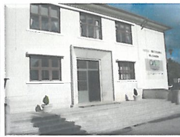
Figura 2 – Fachada Principal da Escola Secundária da Mealhada
