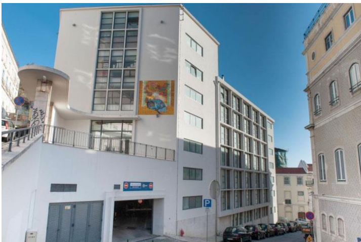
Fig. 22 – Fotografia do Edifício do Mercado do Chão do Loureiro, Lisboa.
