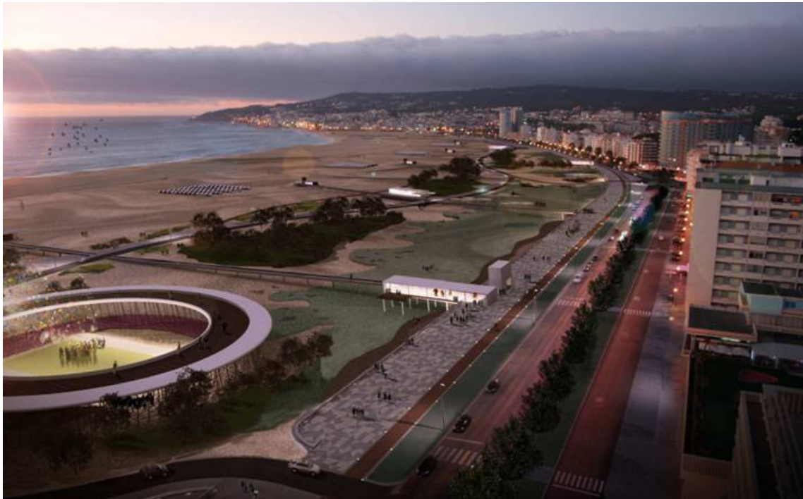
81. Requalificação do espaço público da marginal e da zona de ante-praia.
