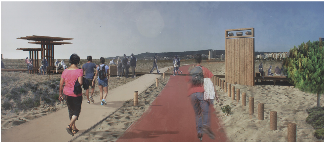
83. Município da Figueira da Foz: Requalificação do areal urbano - projeto em execução.
