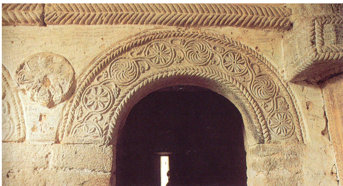
Fig. 206. San Miguel de Lillo, Oviedo Pormenor da decoração interior da igreja, com recurso a abundantes molduras de duplo encordoado de sentido alternado. Séc. IX
