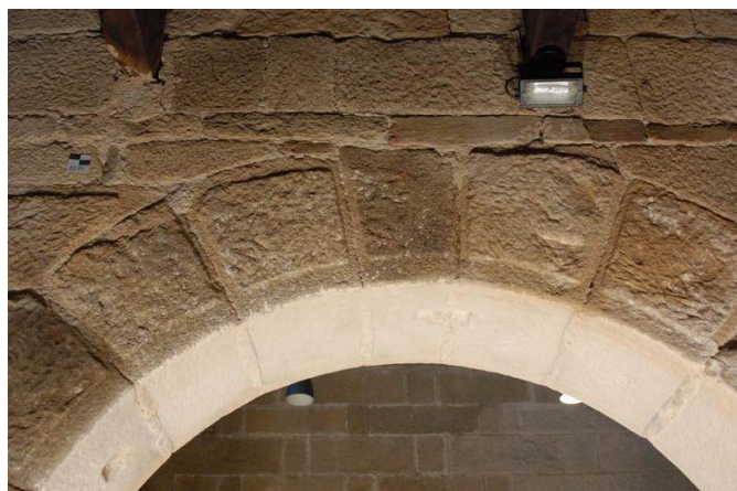
Fig. 114. S. Pedro de Lourosa. Pormenor do almofadado da arcaria Sul do corpo
