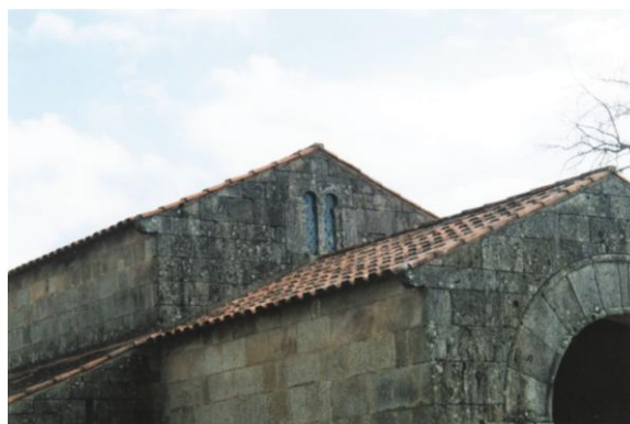
Fig.106. S. Pedro de Lourosa. Aximez original (com mainel reconstruído), recuado da fachada principal do narthex para o alçado do portal principal de ingresso na nave central aquando do restauro
