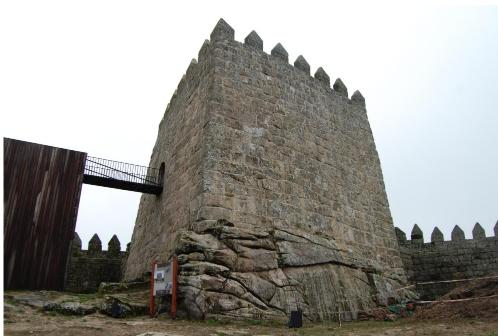
Fig. 182. Fachada ocidental da torre de menagem do castelo de Trancoso
