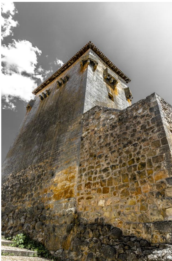
Fig. 189. Torreón de Fernán González, Covarrubias, Burgos. Perspectiva da torre troncocónica e do aparelho construtivo pré-românico nas fiadas inferiores
