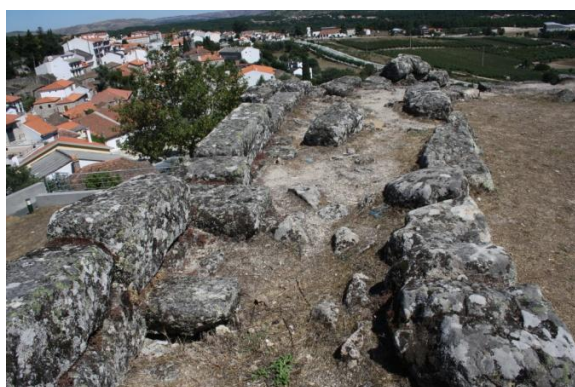
Fig. 222 Aguiar da Beira. Pormenor da largura da muralha da face Norte
