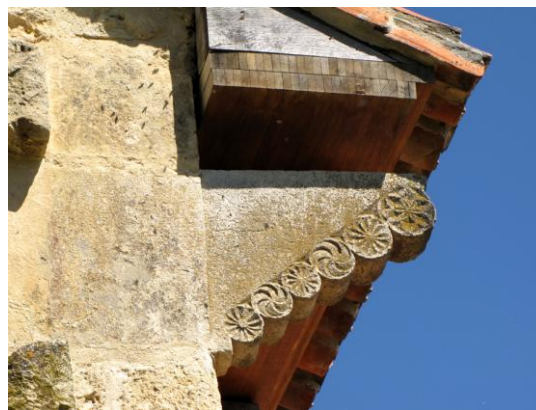
Fig. 75. San Miguel de Escalada. Pormenor do tipo de modilhão de rolo utilizado no edifício
