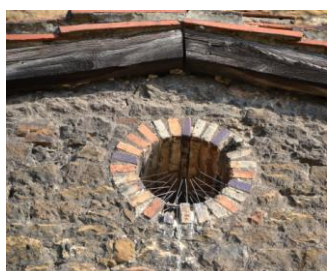
Fig. 77. San Julián de los Prados. Pormenor do óculo de ladrilho na fachada Sul da nave transversal
