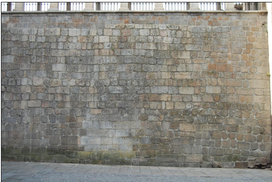
Fig.161. Muralha da Varanda dos Cónegos voltada ao adro da Sé (face setentrional)
