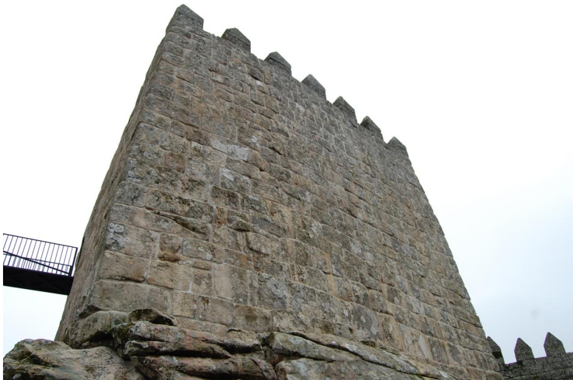
Fig. 185. Fachada ocidental da torre de menagem do castelo de Trancoso
