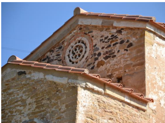
Fig. 74. San Miguel de Lillo, Oviedo. Pormenor da inexistência de modilhões a suportar os telhados
