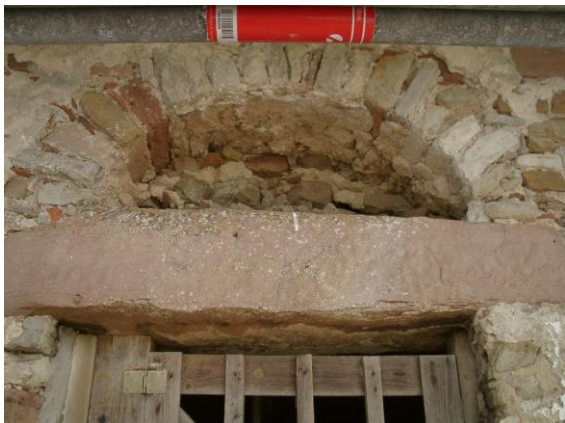
Fig. 86. S. Gião da Nazaré. Lintel e arco de descarga do portal principal
