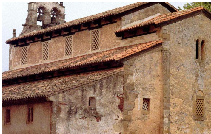
Fig. 143. San Salvador de Priesca. Gelosias do andar térreo da capela-mor e das partes altas da nave central
