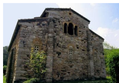
Fig. 78. San Pedro de Nora. Fachada nascente da igreja, vendo-se o óculo em ladrilho na empena da nave central
