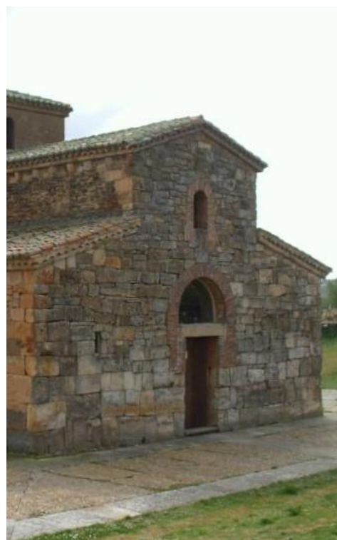
Fig. 89. S. Pedro de la Nave. Fachada principal com portal de lintel recto sobrepujado por arco de descarga
