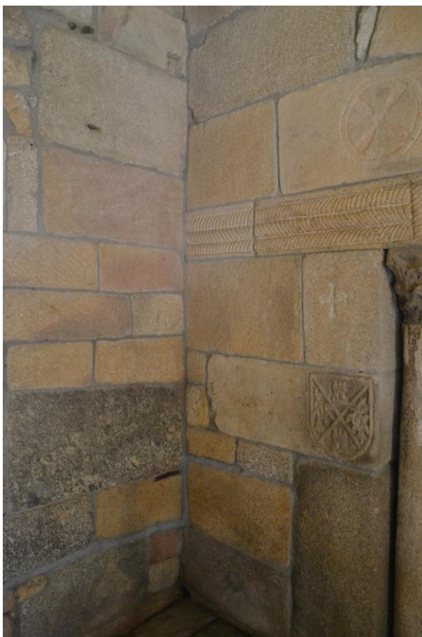
Fig. 61 S. Pedro de Balsemão Pormenor do adossamento do muro que separa as naves central e Norte ao muro onde se abre actualmente o arco triunfal
