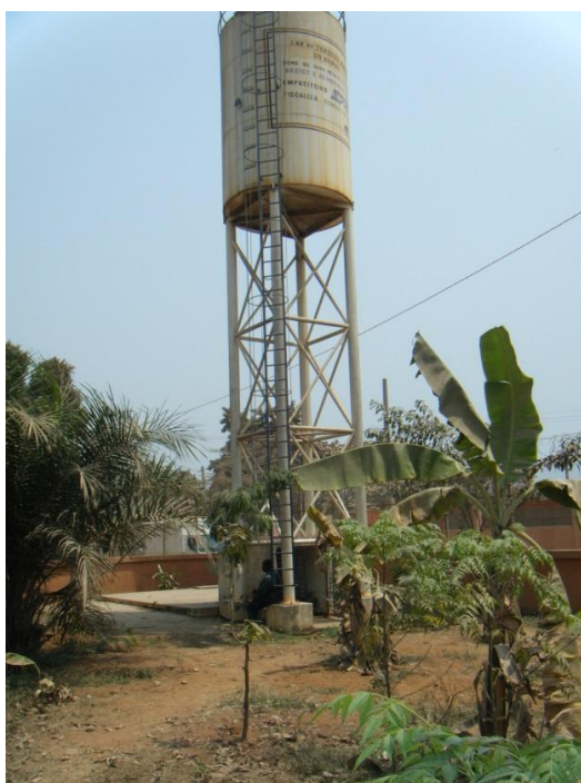
Figura n.º 6: Tanque da água
