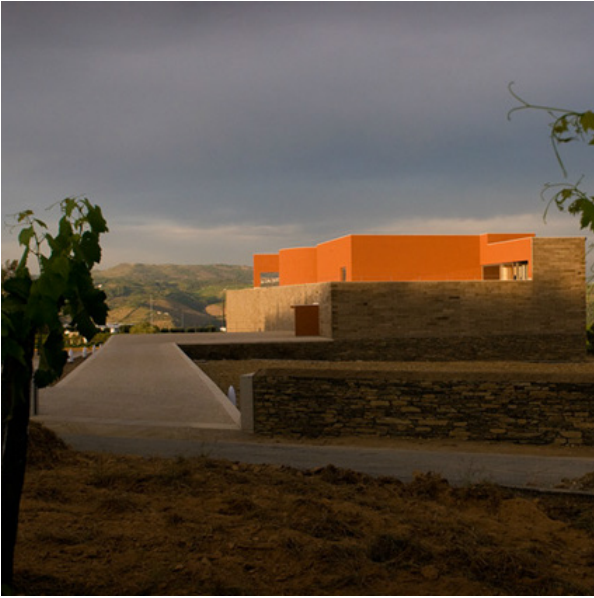
Fig. 40 Quinta do Portal Armazém de Estágio e Envelhecimento
