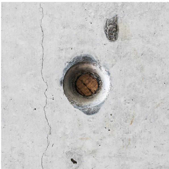
Fig. 105 Adega Mayor Pormenor do betão selado por rolhas
