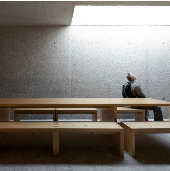
Fig. 80 Quinta do Vallado Betão bujardado e clarabóia na sala de provas
