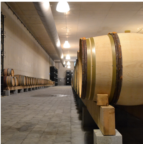
Fig. 82 Adega Mayor Betão aparente e pedra granítica na Sala de Barricas
