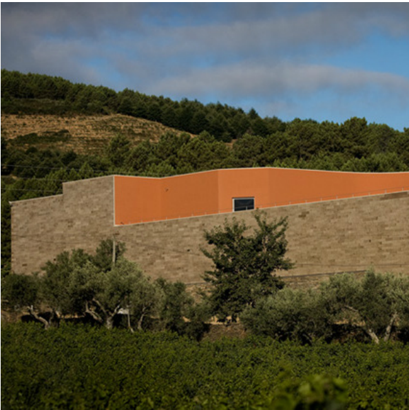
Fig. 41 Quinta do Portal Armazém de Estágio e Envelhecimento
