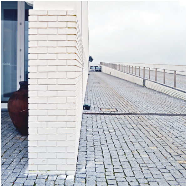
Fig. 81 Adega Mayor Embasamento em tijolo maciço caiado
