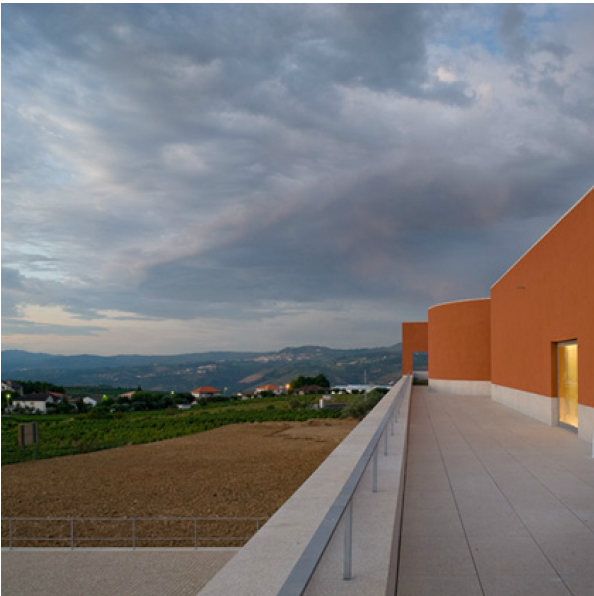
Fig. 88 Quinta do Portal Capoto ocre e mármore na cobertura do Armazém de Estágio e Envelhecimento
