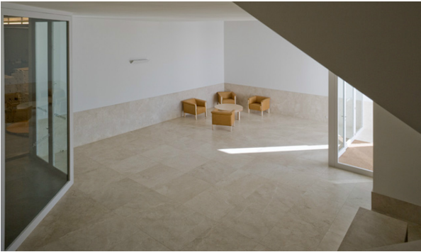
Fig. 84 Adegas Mayor Pavimento e lambris em mármore e paredes e teto estucados no interior
