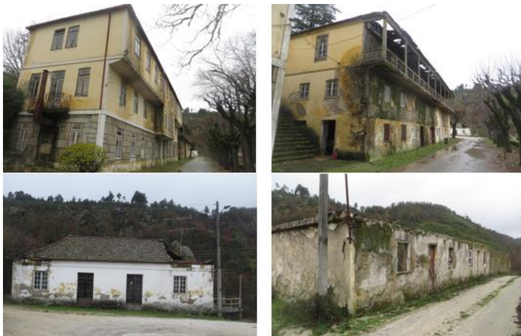
Figura 7.13 Edifícios degradados na envolvente do balneário
