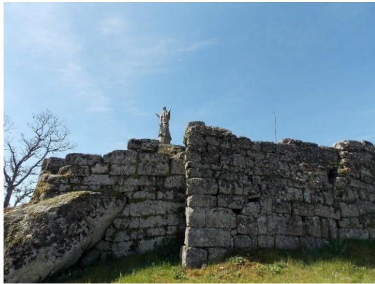
Figura 4.21 Castelo de Aguiar da Beira Fonte: Do autor (2012)
