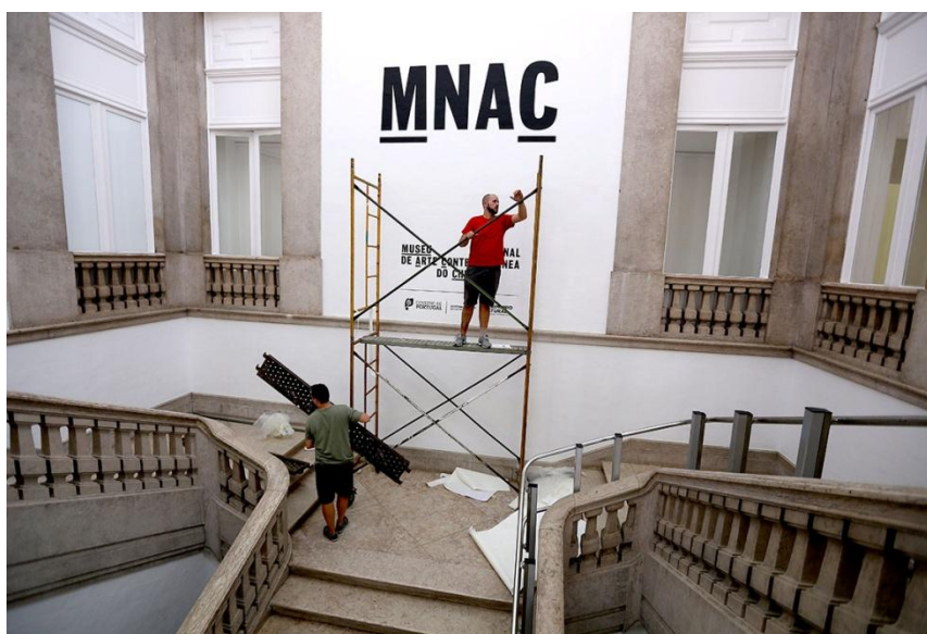
Entrada do novo espaço do Museu do Chiado, ainda em remodelações
