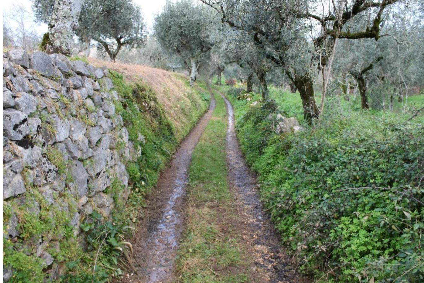
Fig. XXIII. Escorrimento das águas das parcelas para o caminho, a uma cota inferior, em direcção ao rio de Mouros.
