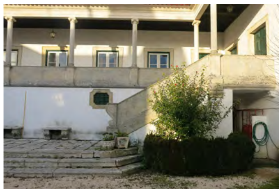
Fig. 119 - Fachada Sul do Corpo Central
