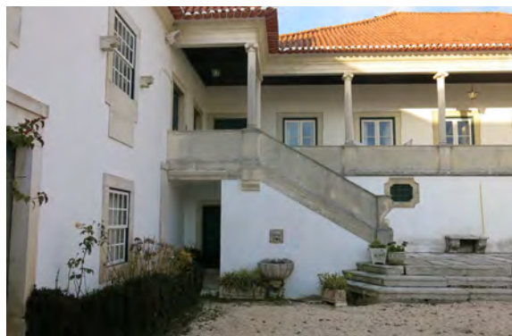
Fig. 117 - Fachada Sul do Corpo Central
