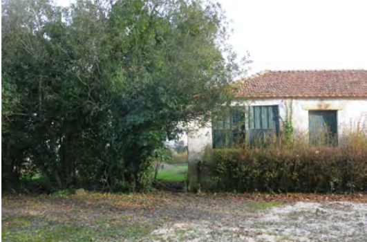
Fig. 222- Adega, fachada Poente
