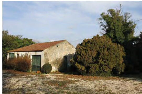
Fig. 221- Adega, fachada Poente
