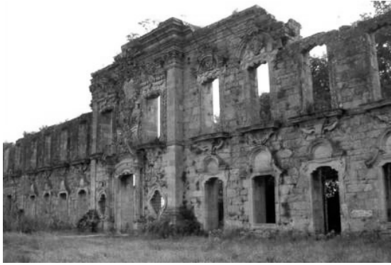
Fig.27- Casa de Vila Boa de Quires
