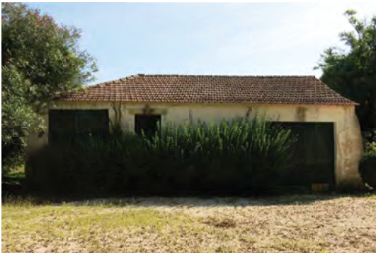
Fig. 220- Adega, fachada Poente
