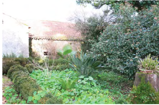
Fig. 219- Adega, fachada Sul
