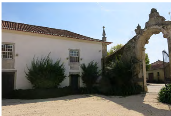
Fig. 111 - Fachada Poente da Ala Nascente
