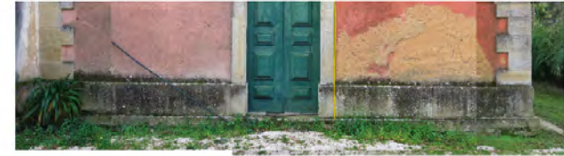
Fig. 232- Matadouro, fachada Nascente
