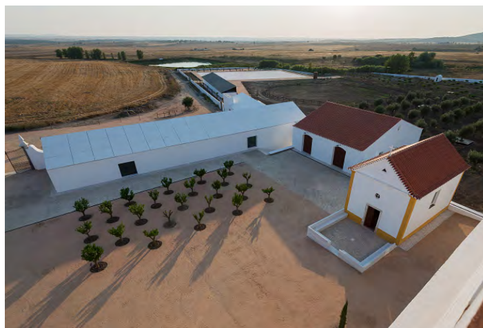
Fig. 276 - Vista da Torre de Palma
