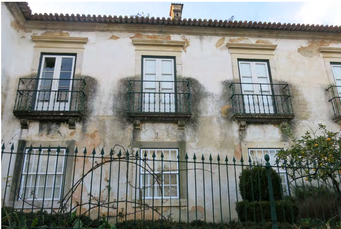
Fig. 91- Fachada Nascente do Corpo Central
