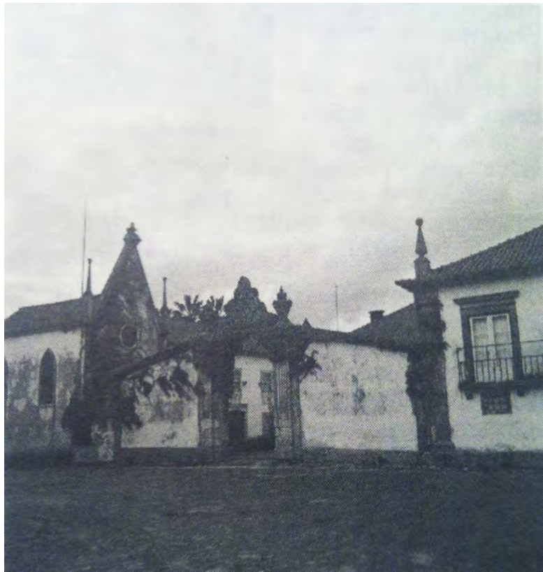
Fig. 98- Paço de Óis , depois da queda da cruz da Capela
