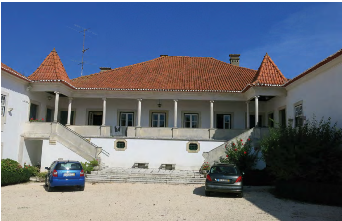
Fig. 72- Fachada Sul do Corpo Central
