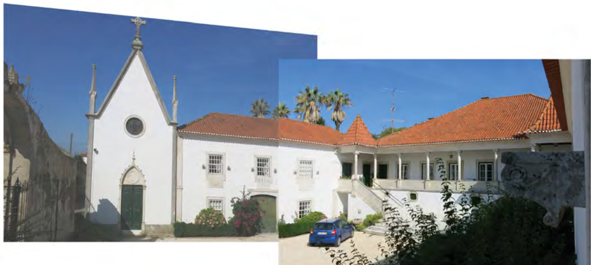
Fig. 81- Fachada Nascente da Ala Poente
