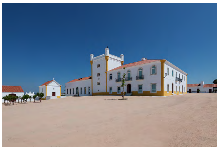
Fig. 256 - Torre de Palma, depois da intervenção
