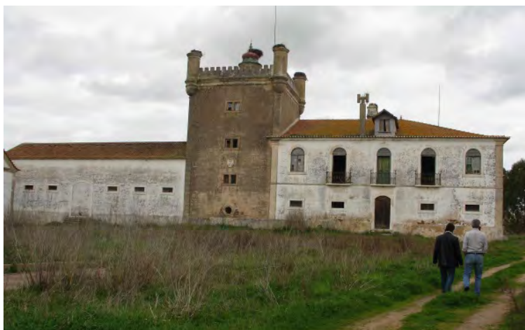
Fig. 255 - Torre de Palma, antes da intervenção
