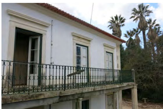
Fig. 126- Fachada Norte do Corpo Central
