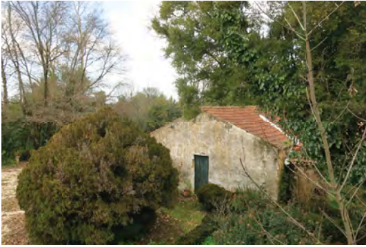
Fig. 218- Adega, fachada Sul
