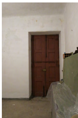
Fig. 183- Quarto de serviço
