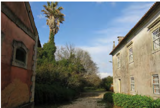
Fig. 234 - Vista do portão
