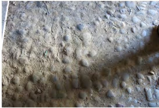
Fig. 291- Pavimento do celeiro
