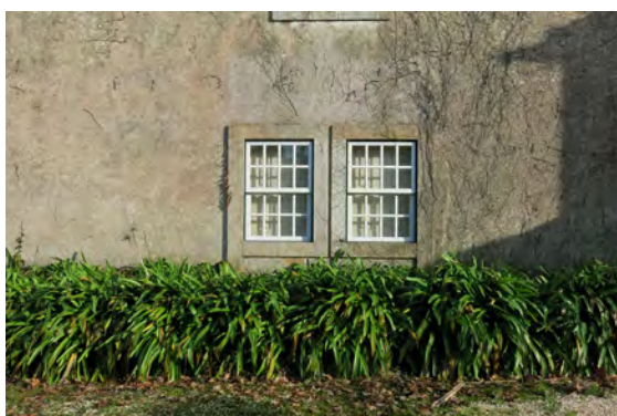
Fig. 124- Janelas da Fachada Poente da Ala Poente
