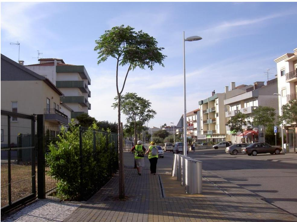
Fig. 38 – Estrada de Minde – Neste ponto, apesar de o passeio ter uma largura de 4 m, a largura útil é de poucas dimensões devido à grelha da árvore, aos ecopontos e ao candeeiro.
