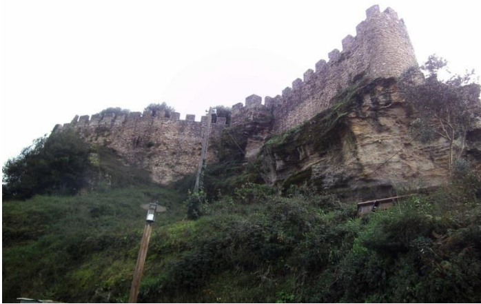
Figura 3 - Aproveitamento do escarpado para construção da muralha Castelo de Penela
