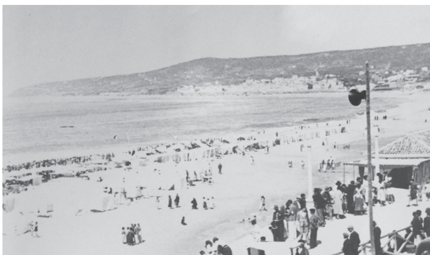
Fig. 43 - Zona Balnear da Figueira da Foz Antes da Intervenção
