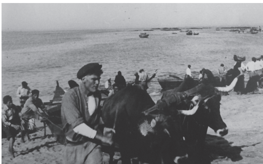
Fig. 44 - Areal de Buarcos Antes da Intervenção
