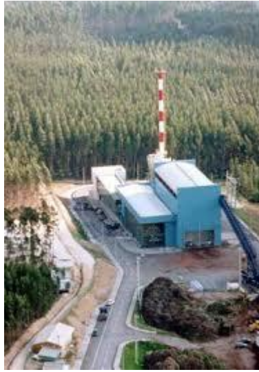
Figura 11 - Central de Mortágua(vista aérea)
