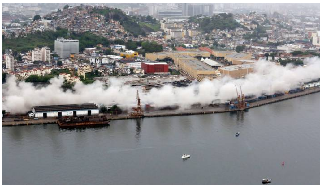
Figura 3: Implosão do viaduto da Perimetral, Centro do Rio de Janeiro Fonte: Beth Santos / Divulgação Prefeitura do Rio
