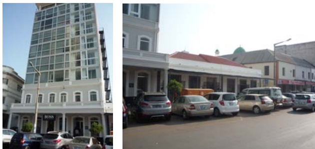
Figuras 83a e 83b: Reabilitação e ampliação na Baixa de Maputo: Av. 25 de Setembro, edifício contíguo à Casa Elefante, 2013, autora. Sobre o antigo edifício de alvenaria, com dois pisos, ergueram-se sete andares em vidro e alumínio, “conservando-se” a antiga fachada.
