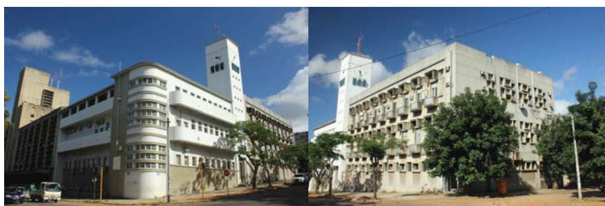
Figura 168: Telecomunicações de Moçambique (antiga Central Telefónica Automática), gaveto da Av. Vladimir Lenine com a Rua da Rádio, [s.d.], [s.a.], CEDH-FAPF.
