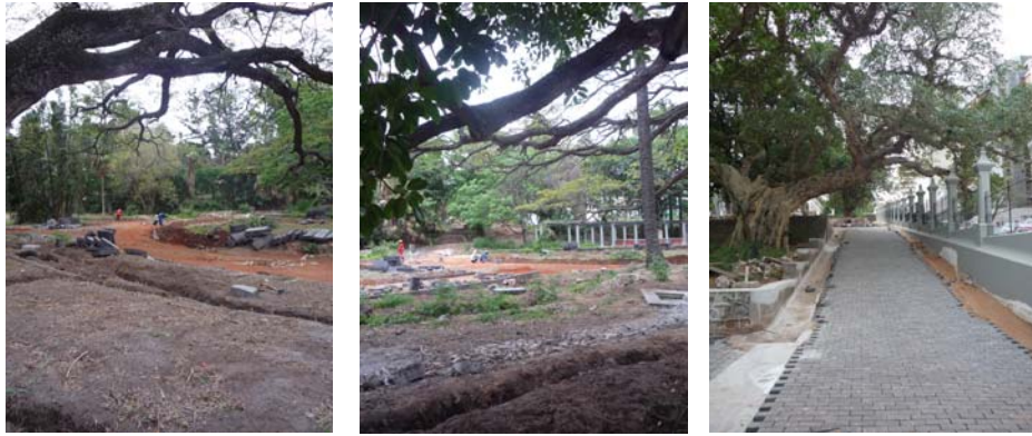
Figuras 181 a 183: Jardim Tunduru, obras de reabilitação, 2014, autora. As duas primeiras imagens mostram as imediações do “lago da pérgula” (substituição da pavimentação e abertura de valas para assentamento de ramais de distribuição de água e coletores para esgoto); e a última, a entrada no ângulo da Av. Vladimir Lenine com a de Zedequias Manganhela, com a substituição da calçada em basalto por pavê.
