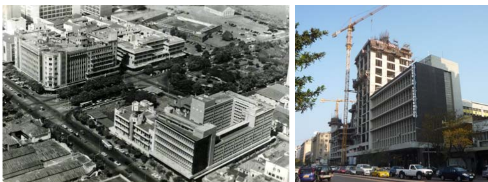
Figura 81: “A Avenida da República, entre o Café Continental e a sede do BNU 29 ”, [anos 1960], [s.a.]. Fonte: The Delagoa Bay World . Disponível em: http://delagoabayworld.wordpress.com/2012/02/22/a-baixa-de-lourenco-marques-na-avenida-da-republica-anos-1960/ [consult. 6 mar. 2014].
