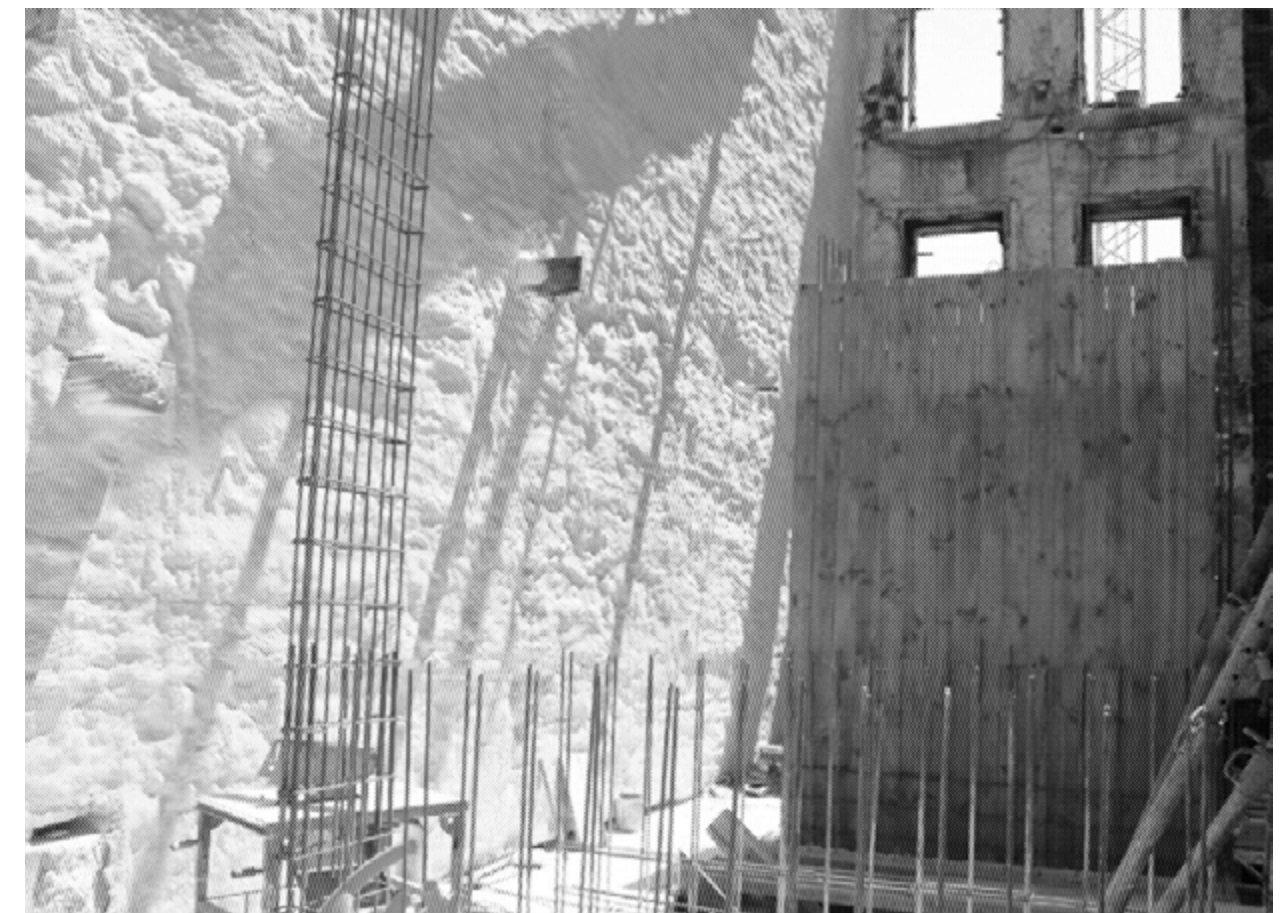
Obras de recuperação e reabilitação do edifício após o incêndio.
