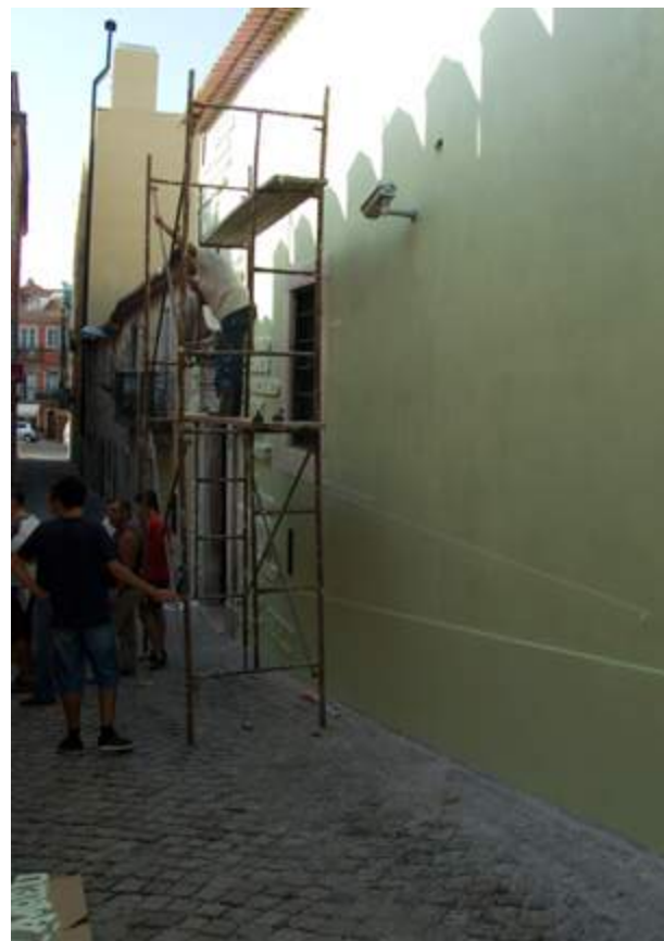
Processo de montagem e instalação dos elementos tipográficos na fachada.
