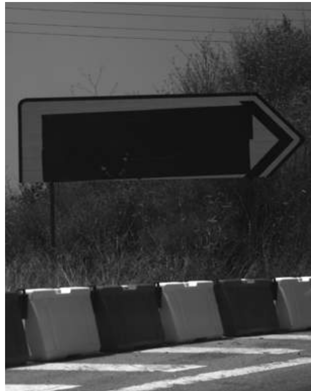
Vinil autocolante oculta temporariamente a informação apresentada nos painéis rodoviários de seleção de via na A28 em Matosinhos. Fotografias que integram a nossa coleção de referências, e serviram de referência ao projeto Em Torno .
