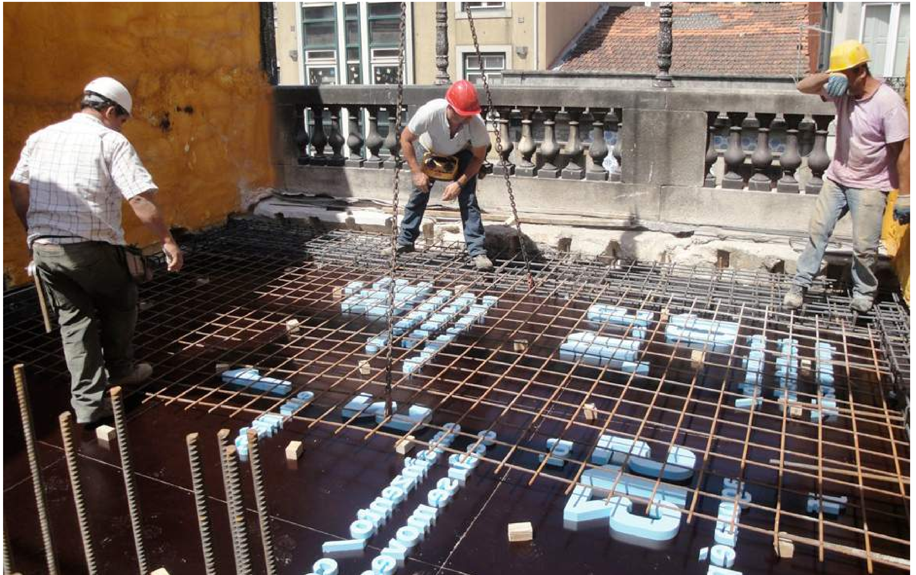
Aplicação das letras de poliestireno expandido sobre painel contraplacado para cofragens (Suite Avenue JF).
