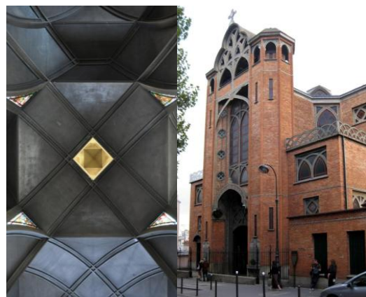
24| 25| Ibidem, visão-tipo das abóbada da nave e fachada principal
