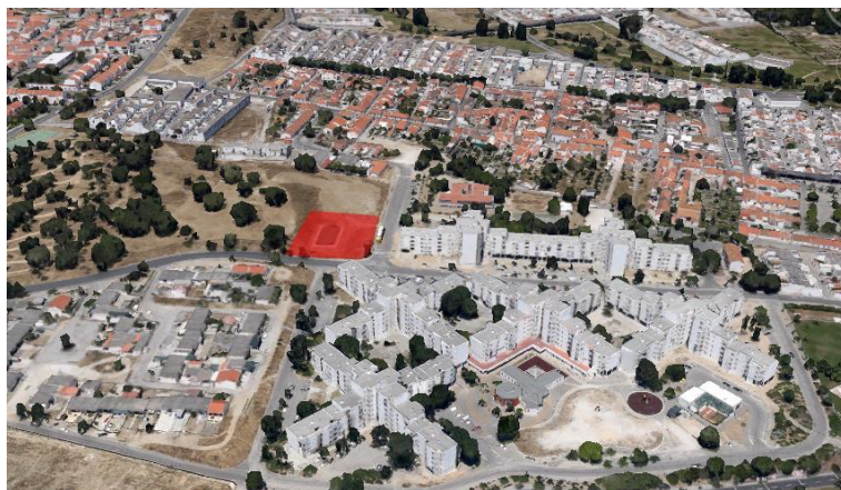
89| Modelo 3D - confronto das duas ordens morfológicas antagónicas, do Bairro Malagueira e as torres do Bairro da Cruz da Picada. Assinalado a vermelho o lote escolhido para o complexo social paroquial de São João Bosco
