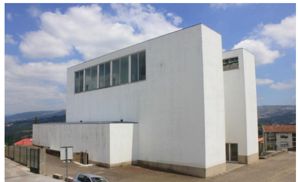
159| Ambiguidade entre exterior e interior
