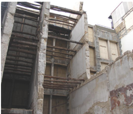
Fig. 15, 16 e 17_ Quarteirão das Cardosas, fachadismo; demolições e novos edifícios dissonantes
