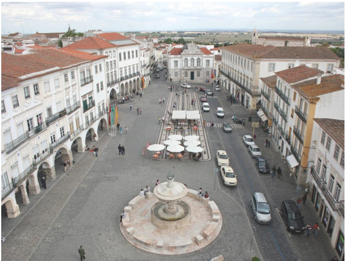
Fig. 84 e 85_ Praça do Giraldo antes e depois da intervenção de 1987 | Évora
