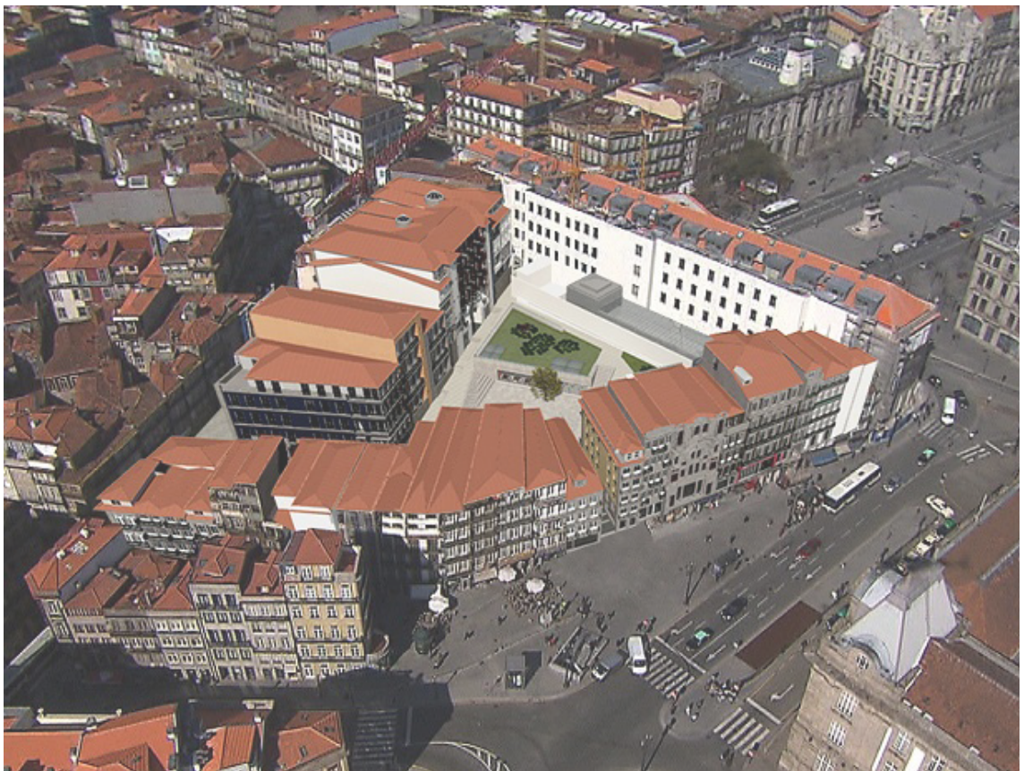
Fig. 13 e 14_ Quarteirão das Cardosas antes da intervenção e 3D do projecto
