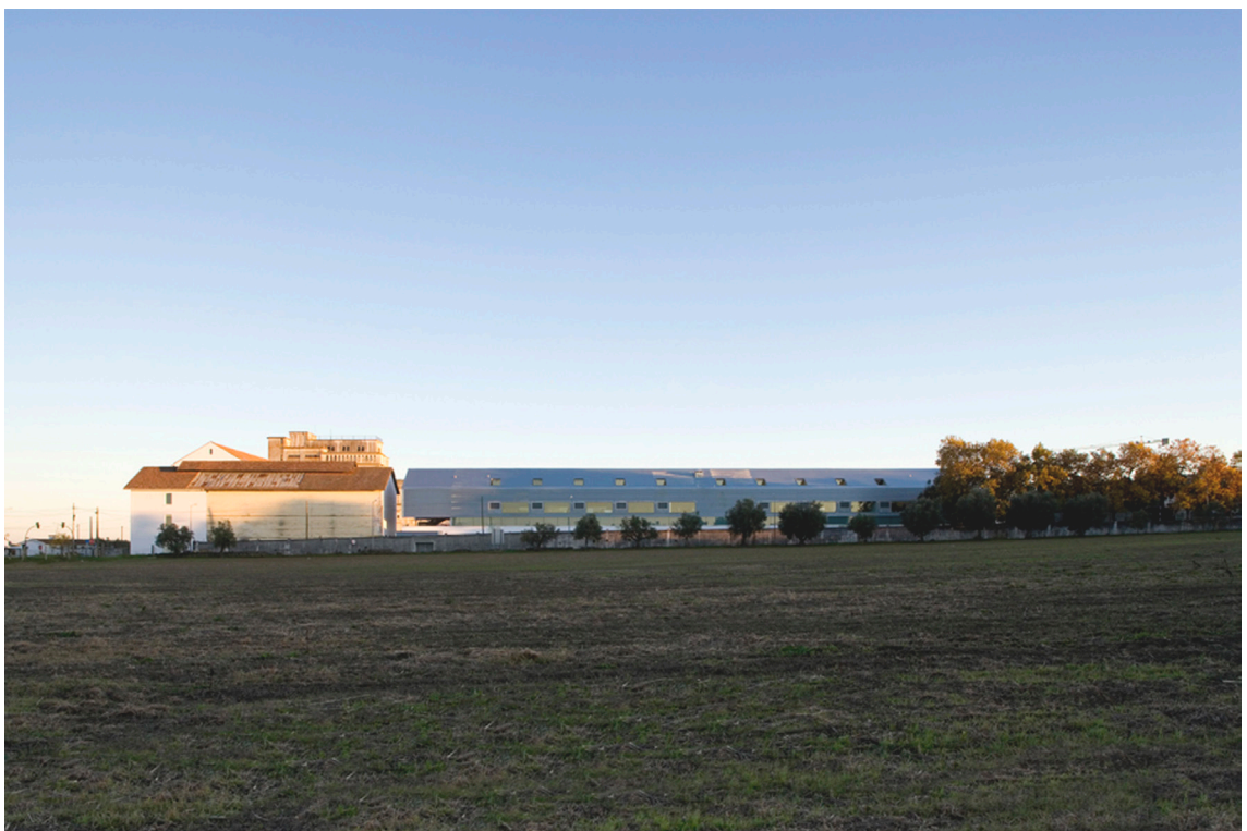
Fig. 117_ Departamento de arquitetura da Universidade de Évora, Inês Lobo
