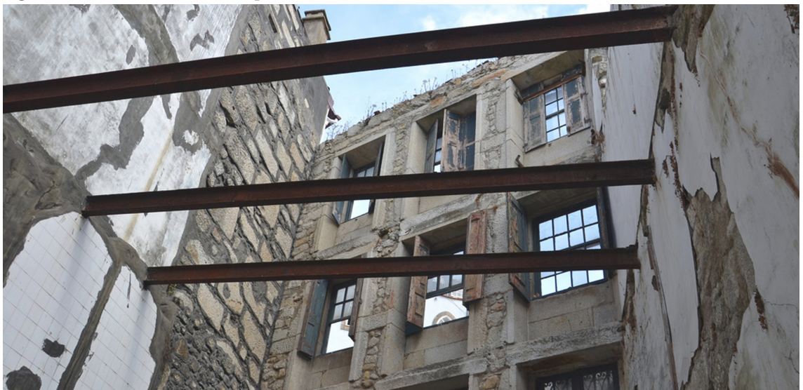
Fig. 165_ Estado de ruína inicial
