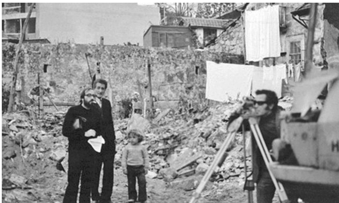
Fig. 138_ Brigada Técnica de São Victor na área de intervenção | Porto
