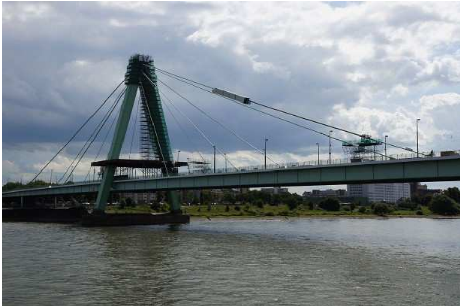
Figura 2.20 – Ponte Severin (Structurae, 2015)
