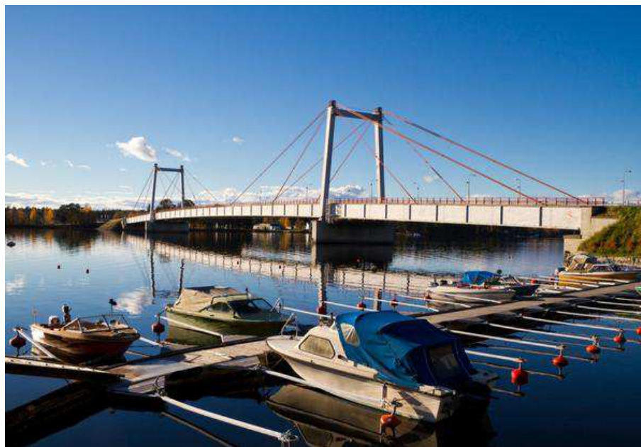
Figura 2.1 – Ponte de Strömsund (Structurae, 2013)
