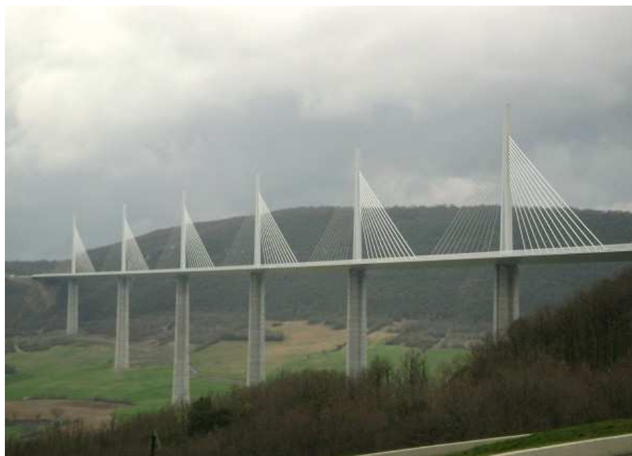
Figura 2.15 – Viaduto de Millau (Structurae, 2013)
