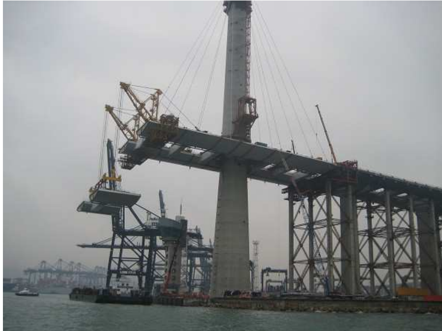
Figura 2.29 – Ponte de Stonecutters – construção do vão lateral com apoios provisórios (Structurae, 2015)
