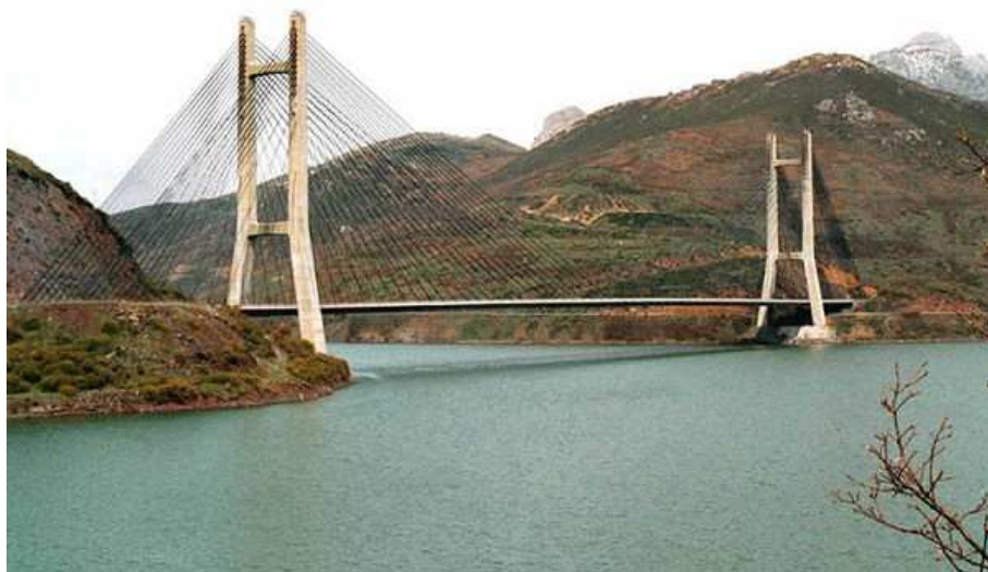
Figura 2.12 – Ponte Barrios de Luna (Structurae, 2013)
