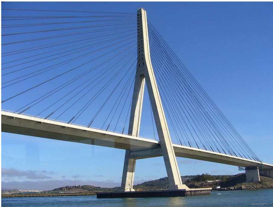
Figura 2.21 – Ponte Internacional do Guadiana (Wikimedia, 2015)
