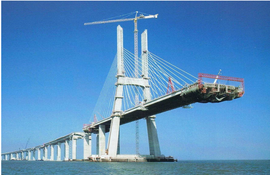
Figura 2.32 – Ponte Vasco da Gama – construção por avanços sucessivos com betonagem “in situ” (GATTEL, 1999)
