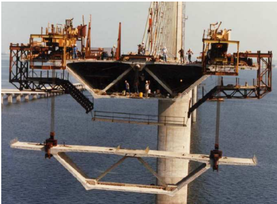
Figura 2.33 – Ponte Sunshine Skyway – elevação de aduela pré-fabricada (Pedro, 2010)
