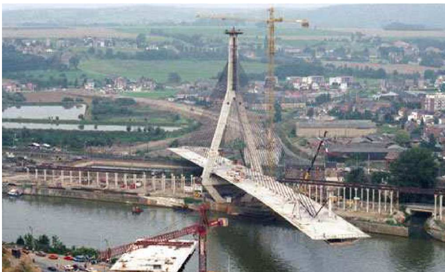
Figura 2.30 – Ponte de Ben Ahin – construção por rotação (Cremer, 1990)
