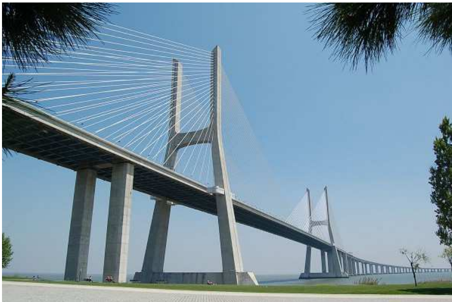
Figura 2.10 – Ponte Vasco da Gama (Structurae, 2013)
