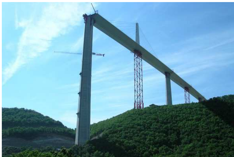
Figura 2.31 – Viaduto de Millau – construção por lançamento incremental (Structurae, 2015)
