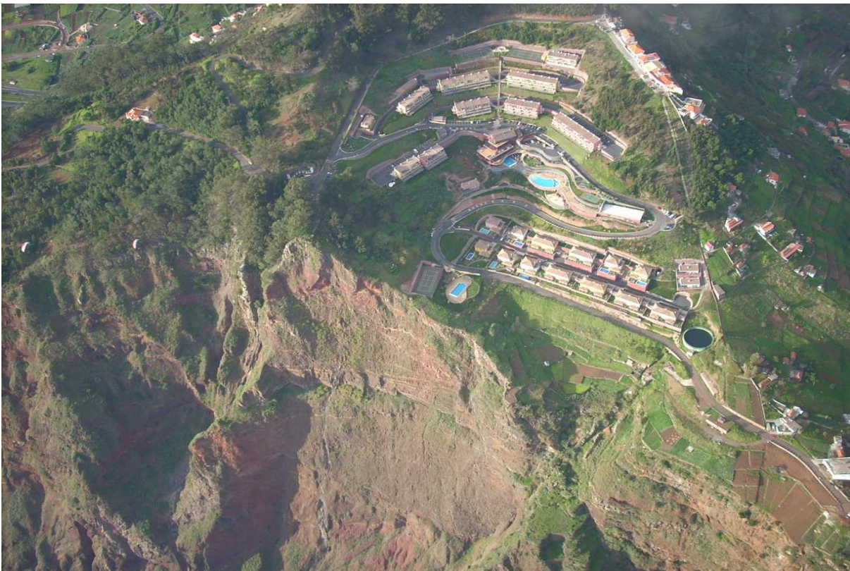
FIGURA VI.10 Cabo Girão (Câmara de Lobos). Edificação de um complexo hoteleiro no limite crítico superior de numa área de elevada perigosidade aos movimentos de massa.
