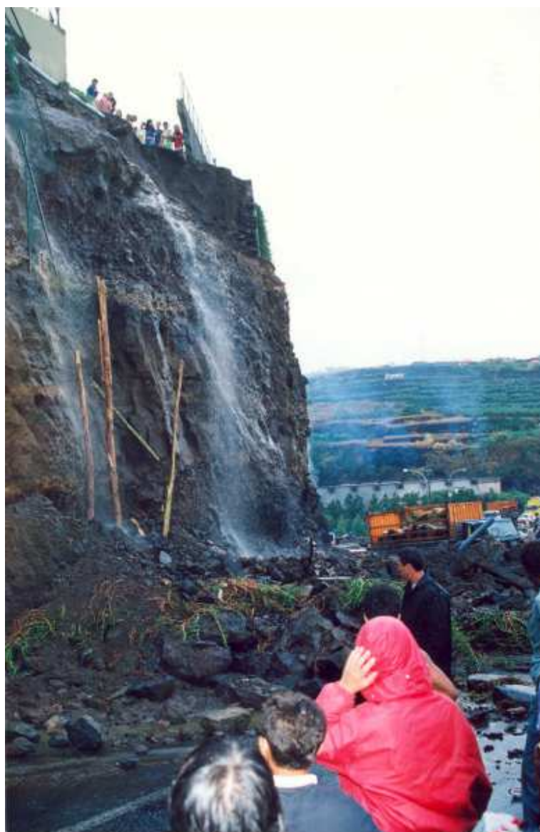
FIGURA V.10 Orla Costeira de Câmara de Lobos. Desabamento de 23 de Setembro de 1991.
