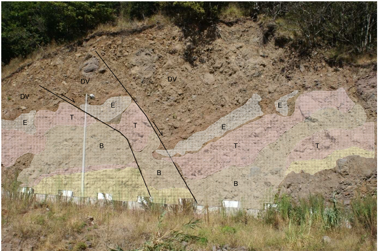
FIGURA V.24 Seara Velha (Curral das Freiras), corte do deslizamento. Legenda: Dv, depósito de vertente; E, escoada lávica; T, tufo e B, brechas.
