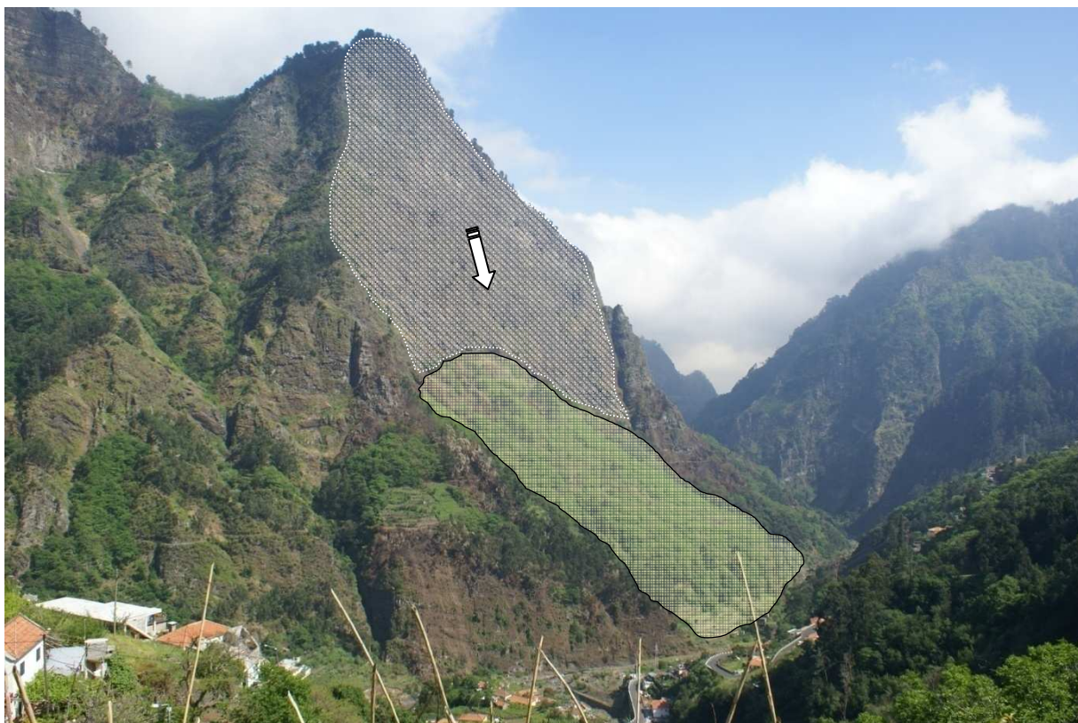
FIGURA V.18 Pico do Serrado (Curral das Freiras), talude subvertical que ascende aos 600m de altura.
