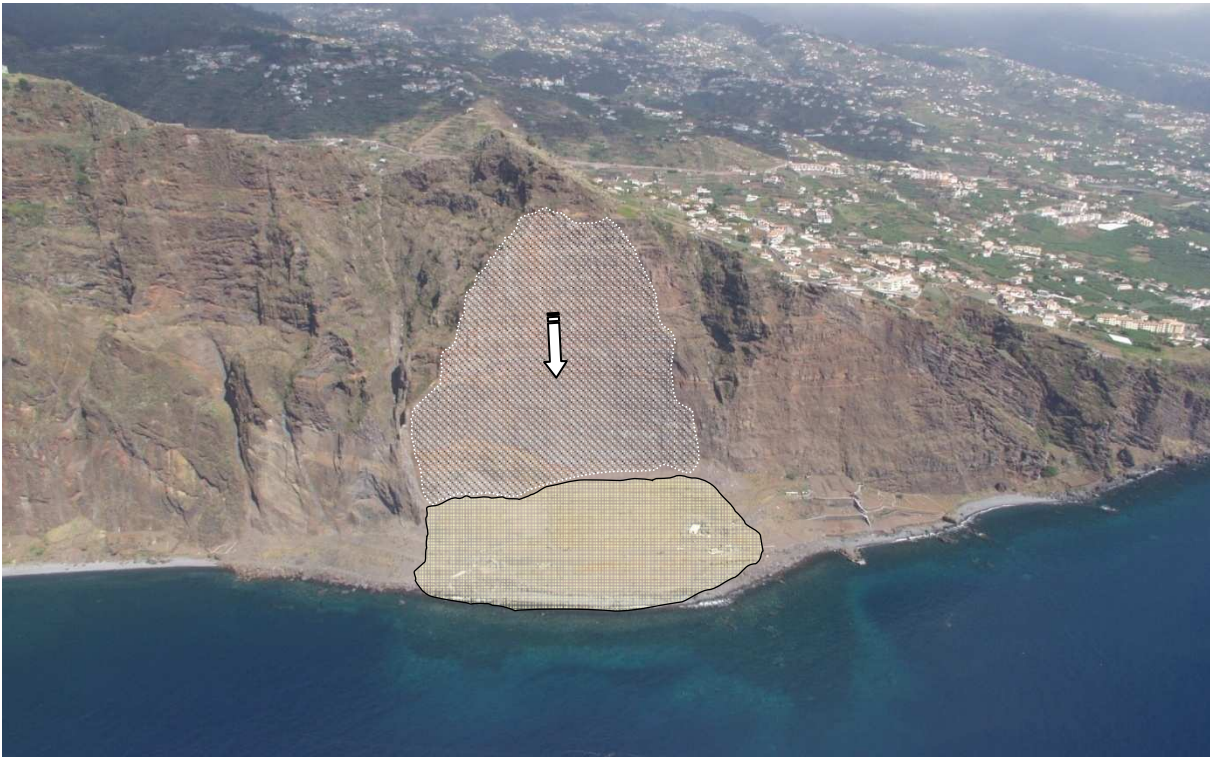
FIGURA V.6 Talude costeiro do Pico do Facho (Câmara de Lobos). Enquadramento geográfico do desabamento de 1930. FONTE: DRAmb.
