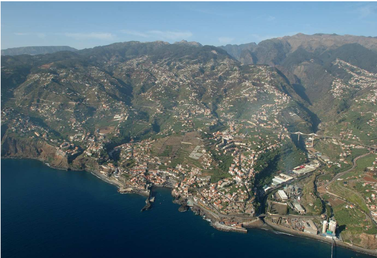
FIGURA IV.16 Câmara de Lobos. Morfologia típica de ilhas vulcânicas, com a existência de escoadas lávicas que submergem no Oceano. Fonte: DRAmb.
