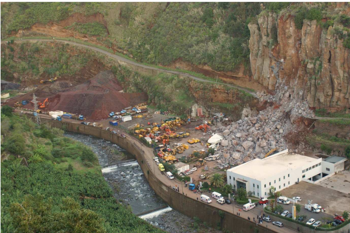
FIGURA V.17 Ribeira dos Socorridos, a 22 de Novembro de 2007, aquando do desabamento.
