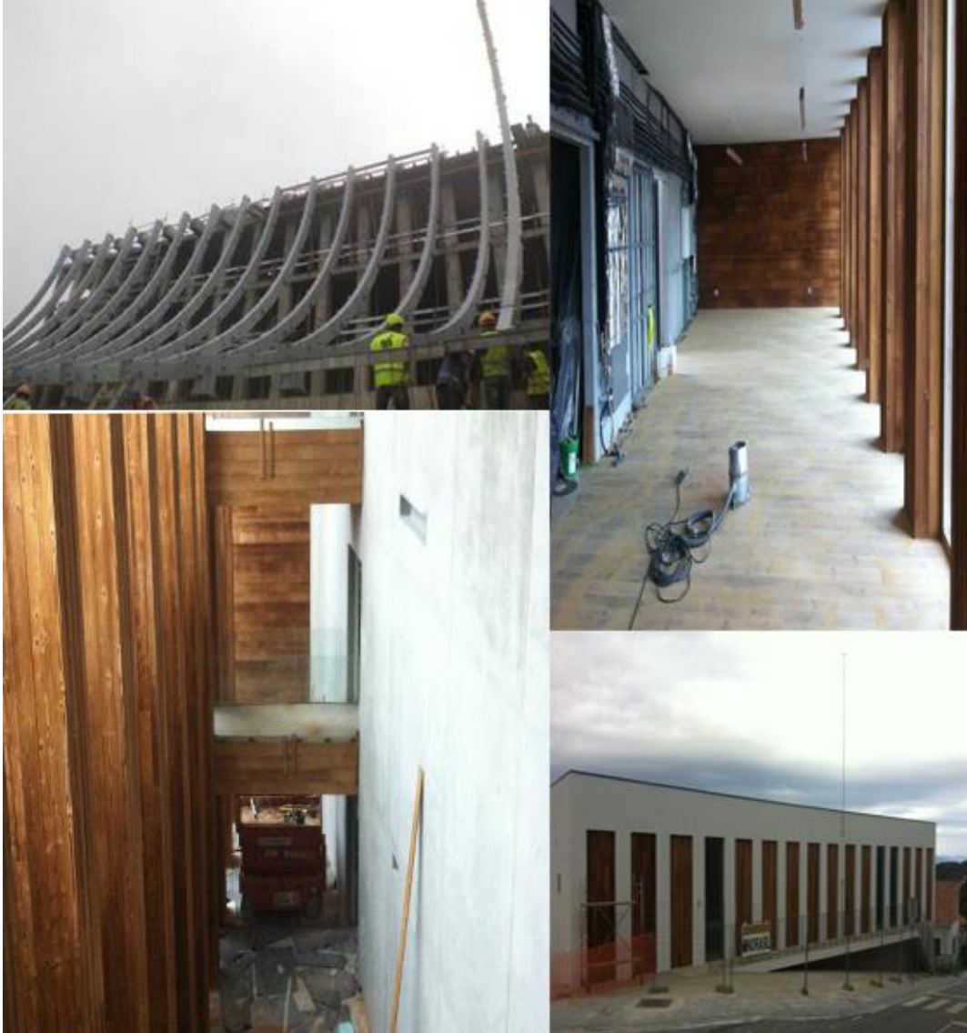
Ilustração 17 : Fases de construção do MVP.
